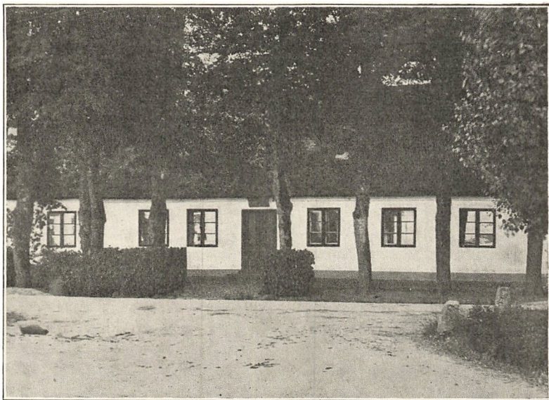
Store Rørbæk ombyggede Rytterskole, der sammen med enkelte andre stadig benyttes som Skole.
