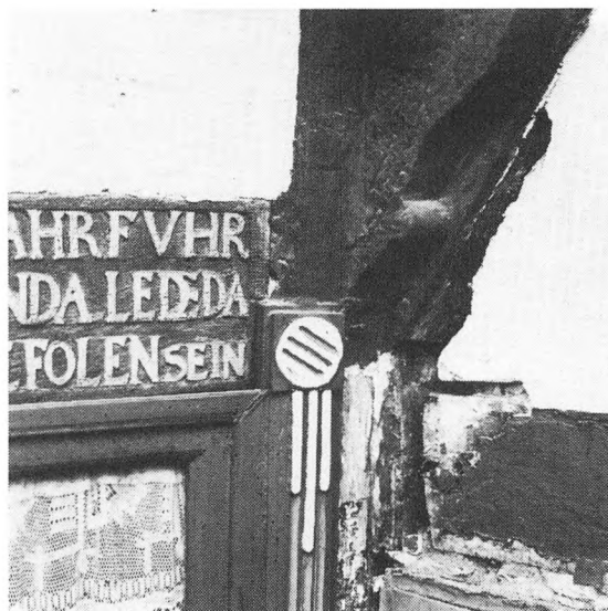
Knægten i karnappens nordside. At den ene halvdel er profileret og den anden blot lige, viser at karnappen ikke er tilkommet senere, men er opført samtidig med huset.
