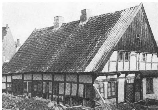
Kirkegade 8 ved begyndelsen af den store restaurering.
