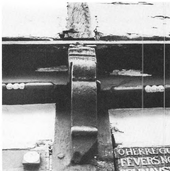
En af de profilerede knægte der bærer gadegavlens udkrængning. På begge sider af knægten ses det dekorerede fyldtømmer.
