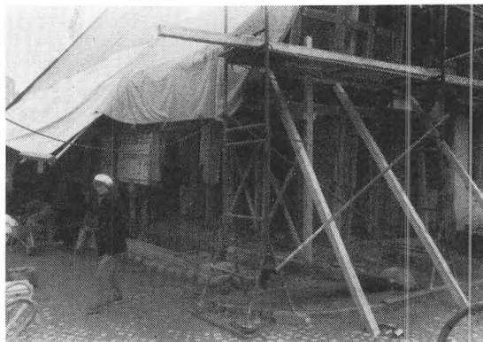
Huset under restaurering, afdækket med presenninger.
