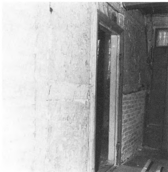
Bindingsværksbygget skillevæg med lerklinede tavl mellem dielen og karnapstuen.
