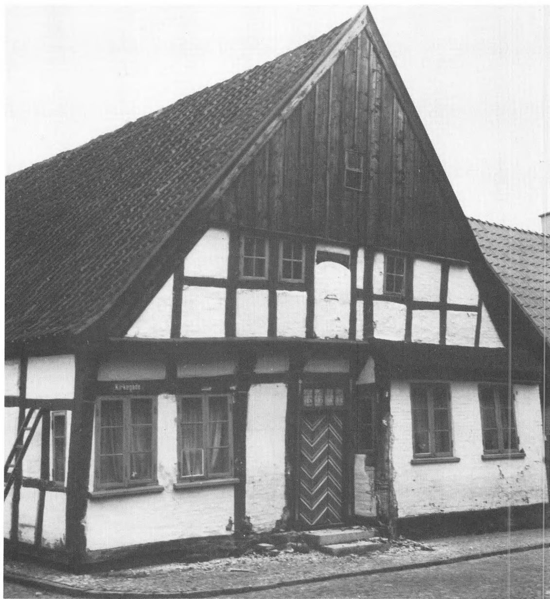
Gadefacaden før restaureringen.
