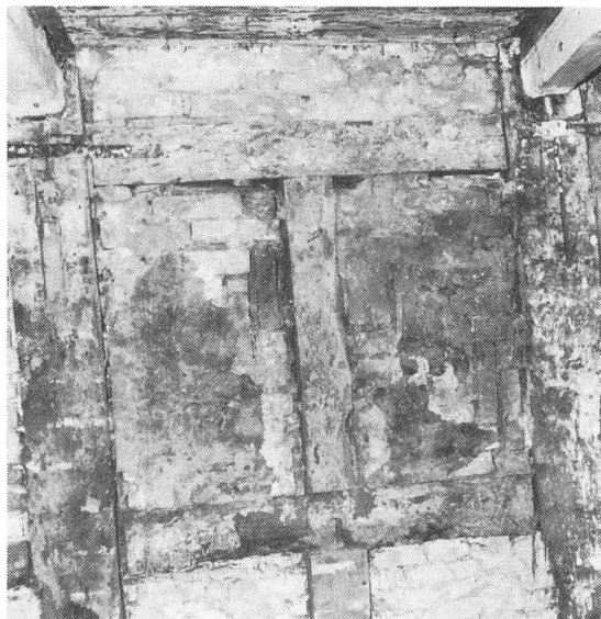
Den indvendige side af de originale, mønstermurede tavl, med rester af den oprindelige vægfarve.
