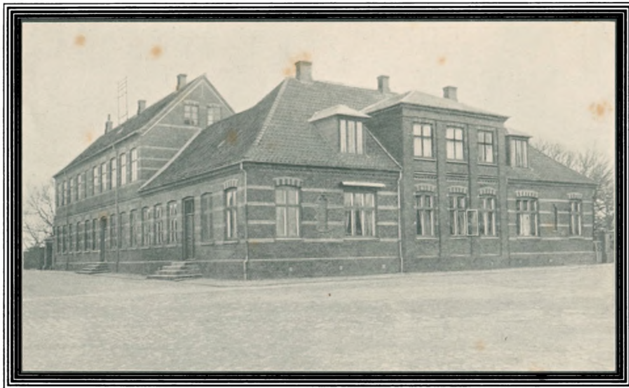
DEN GAMLE KONTORBYGNING OG DIREKTØRBOLIG
