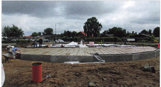
Fundamentet er støbt. Juni 2016
