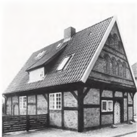
I Wörden i Dithmarschen ligger dette forunderlige hus fra 1519. Det har bindingsværk for ned og grundmur for oven i gavlen. Den slags huse var forhen almindelige og skal have forekommet helt op til egnen omkring Tønder. Tagkonstruktionen er ny. Oprindelig har huset antagelig haft kamtakke gavle. I dag omdannet til beboelse.
