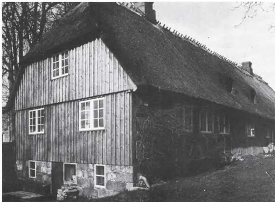
Den ene gavlf på Grønholtgård er med bræddeklædt bindingsværk. Soklen er af store, vel tilhugne kvadre.
