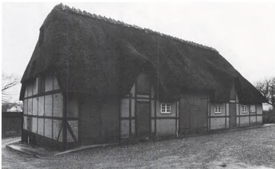
Ladebygning med brunt afstolpet tømmer og røde tavler i Asserballe Skov. Bemærk de spidse kviste over lugerne og det stejle tag med lyshul for oven.
