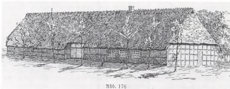
Gård fra Nordangel, som den så ud i gammel tid med alt under samme tag og indkørsel til ladeafdelingen i midten. Tegning af Hans Dall. Efter Meiborg.
