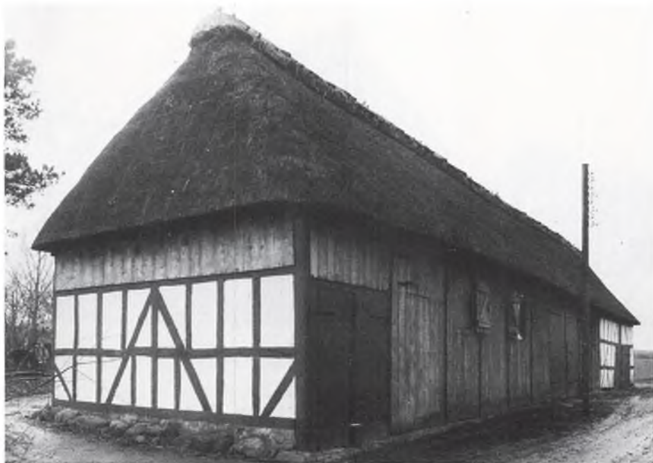
Hjelmen på Asserballe præstegård går helt tilbage til 1637. Der er både udmurede tavl og brædebeklædt bindingsværk. Tømmeret er rødt afstolpet.
