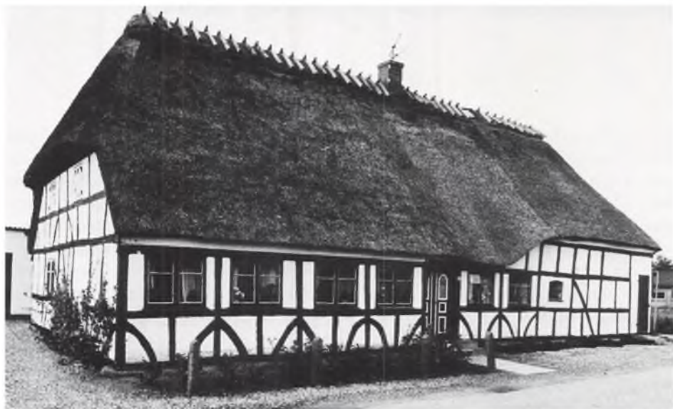
Alserhus i Stolbro med høj ladeafdeling hvori er anbragt en ranke, hvis bestemmelse synes lidt gâdefuld. Beboelsesafdelingen har halvranker – korte skrâbånd – ved stolperne.
