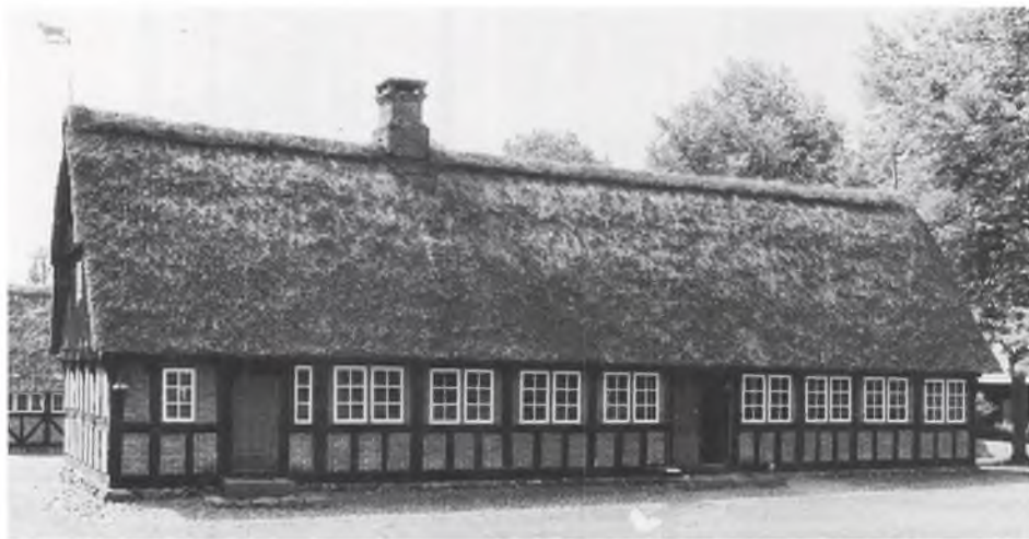
Bindingsværkshus fra Stevellt fra 1700-årene, nu på Haderslev Museum. Skorstenen viser, at der kun har været ét ildsted. For neden støttes den udkragende, bræddebeklædte gavltrekan af små knægte.
