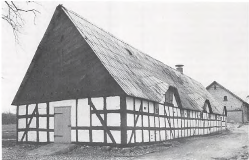
Bevaret avlsbygning på Mjelsgård med rigt og tæt rødmalet bindingsværk. Alle jagene er tre taul høje. Huset har nu pladelag.
