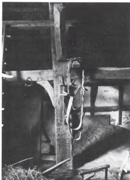
I Husum har man et lille frilandsmuseum med nogle få bygninger. Dette er højremskonstruktionen i en gård fra Ostenfeld. Det ret smalle stykke tømmer foroven er selve højremmen. Længere nede ses forbindelsesbjælker, der går mellem stolperne. For oven er der en tværgående bjælke. Alle overgange støttes af med svære kobbånd. For neden er stolpen tappet ned i en fodrem.
