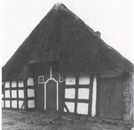
Gavlen af lille hallehus i Wohlde i Vestslesvig. Porten ligger tilbagetrukket i gavlen. Dette parti af huset er fra ca. 1642.
