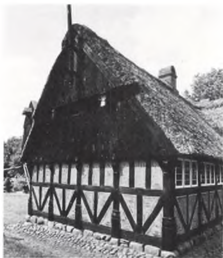
Gavlen på Hejsager-huset. Man ser de lange nag-leender, som rager uden for brædderne. Stolperne er både udskårne og med stolpeskel, og tavlene er mønstersat.
