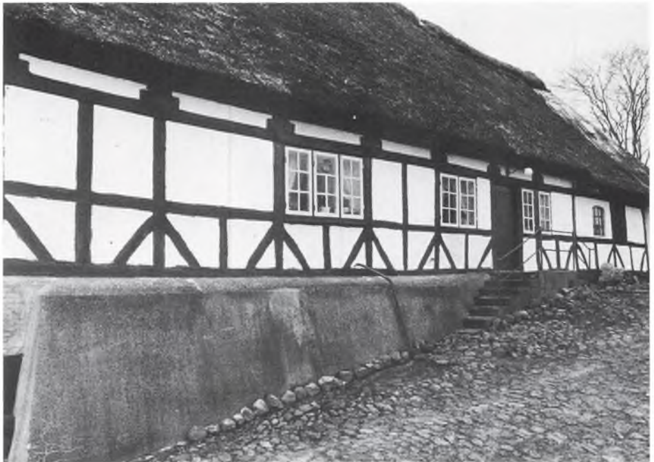
Mange Alserhuse har høj sokkel. Her har man befæstet den med en cementstøbning. Sebbelev.
