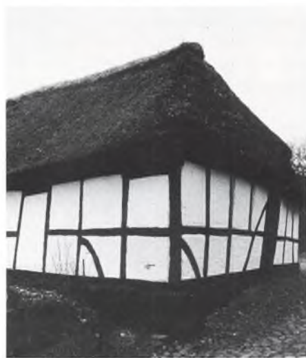
Udhus i Sebbelev på Als, hvor man i gavlens midter ser en ranke skære gennem faget, hvilket har gjort, at dokken i det nederste tavl har måttet udelades, medens der er dokke i det øvre tavl.
