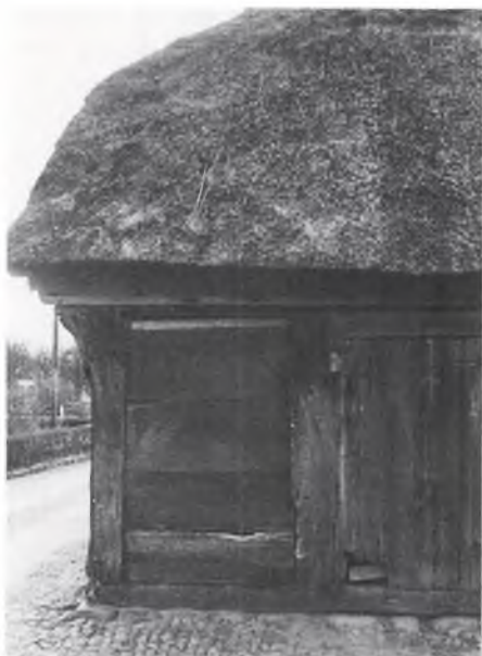
Ørby-laden er af meget svært tømmer, – eg, hvis blødere partier er bortslidt i over en centimeters dybde. Gavltekanten understøttes af knægle, og der er profileret sugfjæl.
