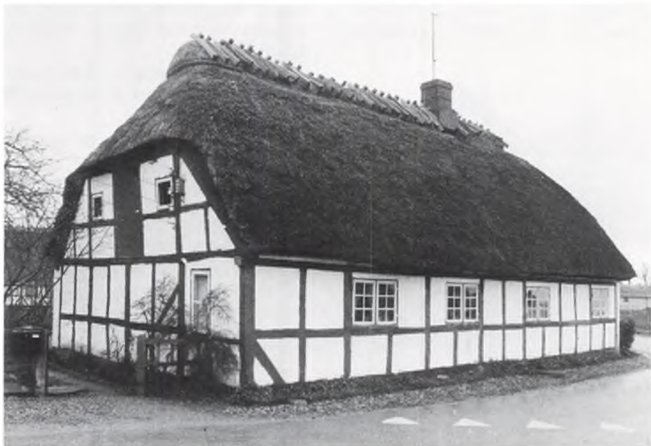
Typisk alsertag med halmvalk under monningen. Stevning.
