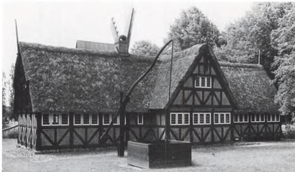
Stuehus fra Hejsager fra omkring 1700. Det rige, svære bindingsværk er typisk for Sønderjylland. Sylten er ganske lav. I alle gavle er der udskårne og profilerede husbrænde. Haderslev Museum.
