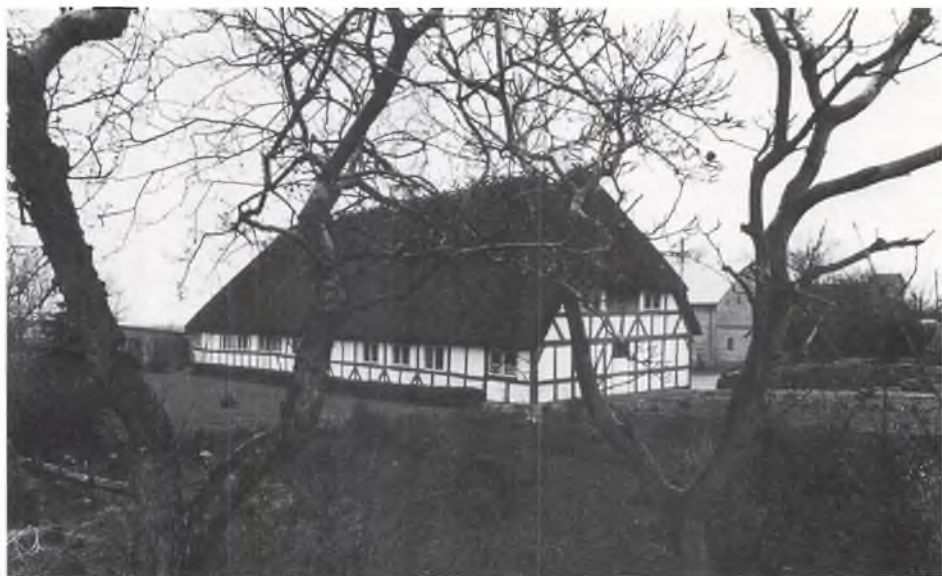
Stuehus til en gård i Spjellerup i perfekt stand. En fuldgod repræsentant for det rigere alske bindingsværk. Tømmeret står rødt, tavlene hvide. Hvis alle danske bindingsværkshuse blev holdt sådan vedlige, var her sandelig noget at se på.
