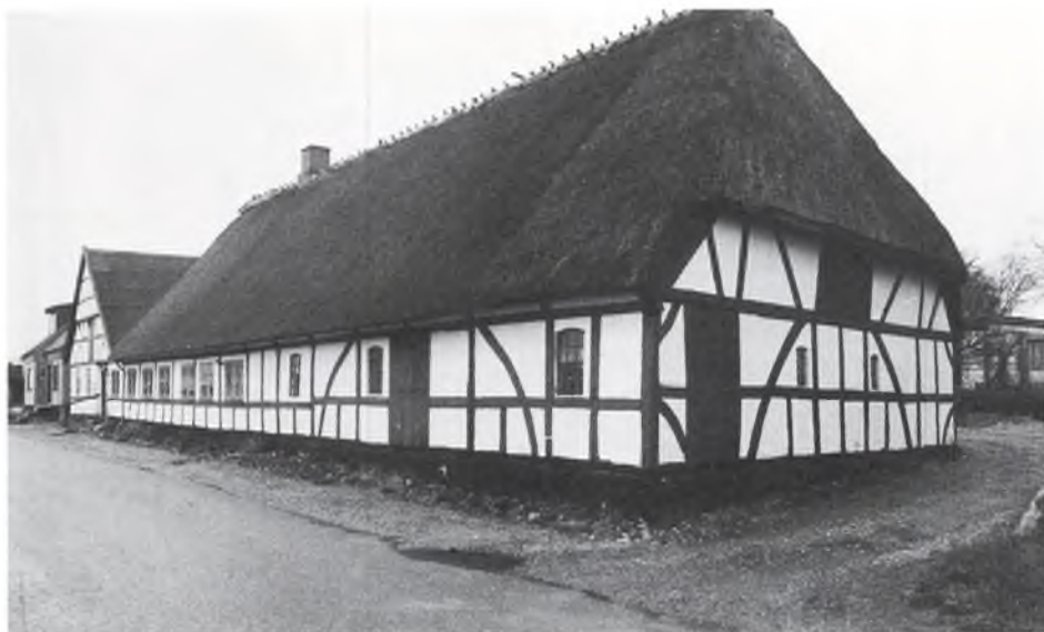
Ladebygning i Egen med maleriske ranke-, og skråbåndskonstruktioner i gavlen.
