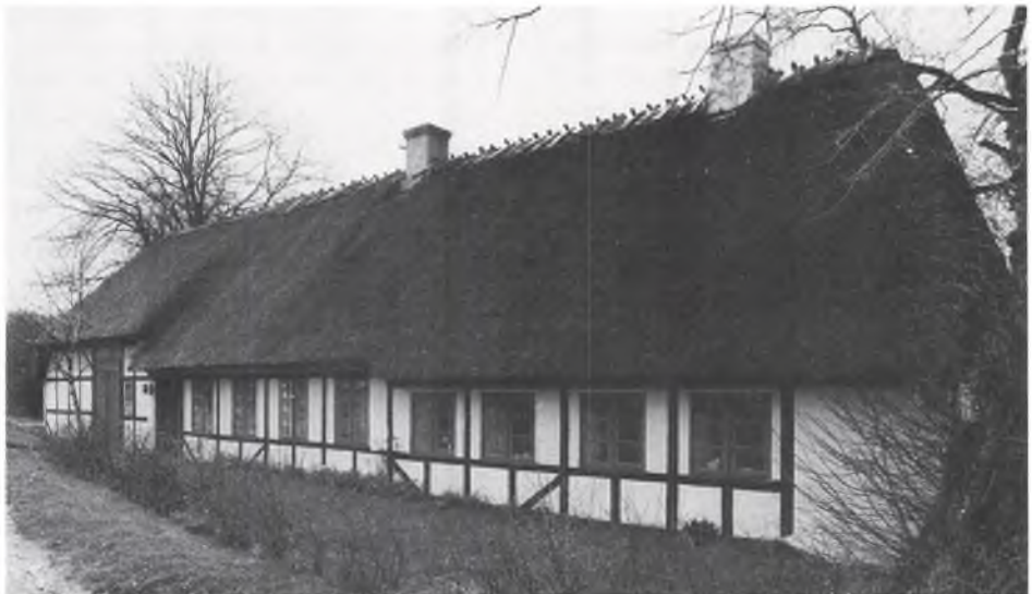
Boelssted i Majbølle, som ligger i tre trin. Tagryggen er derimod snortlige.
