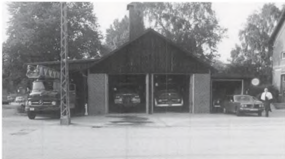
Den 1.5.1952 tages brandstationen på Ravnsnæsvej 5, (nu Dambakken) i brug. Til højre ses garagen der blev tilbygget i 1969 og til venstre stigegaragen der blev bygget i 1974. I baggrunden skimtes slangeårmet, hvorpå sirenen sad.
