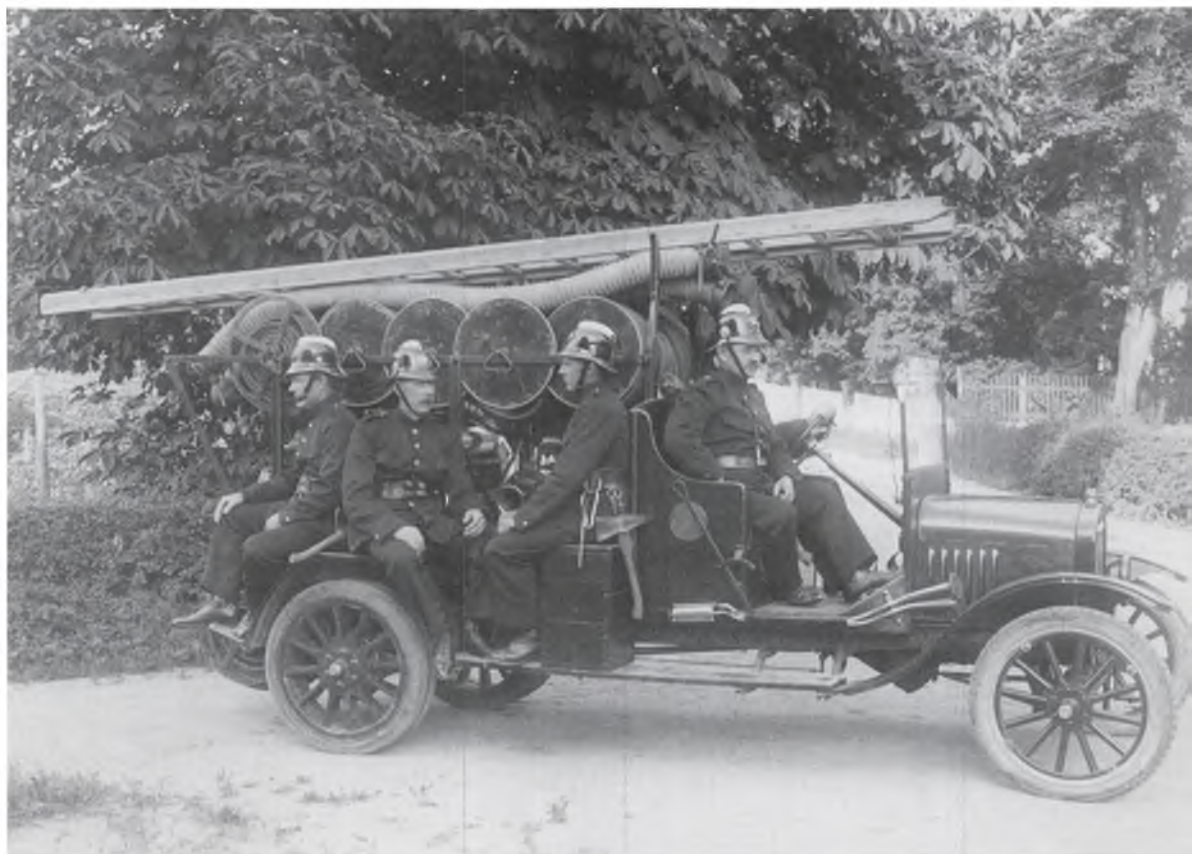
Birkerød Brandvæsens 1. motorsprøjte, en Ford-lastvogn, der blev opbygget af mekaniker N. P. Hansen. En rigtig brandsprøjte, Nordsjællands flotteste køretøj i 1923.
