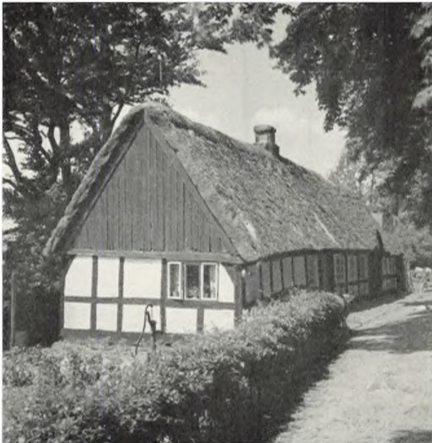
Husmandshus i Ødis-Bramdrup syd for Kolding. Huset, der har fået et moderne vindue i gavlen, er dateret 1733. Årstallet står over døren til den lille stald i husets fjerneste ende. (Fot. 1951 Peter Michelsen).
