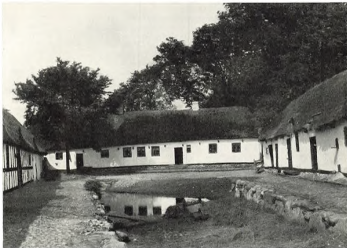
Det meste af gården i Albøge i Djursland er helt hvidkalket. Bjælketappene ses som mørke pletter på stuehusfacaden. I forgrunden møddingen. (Fot. 1929 Halvor Zangenberg).
