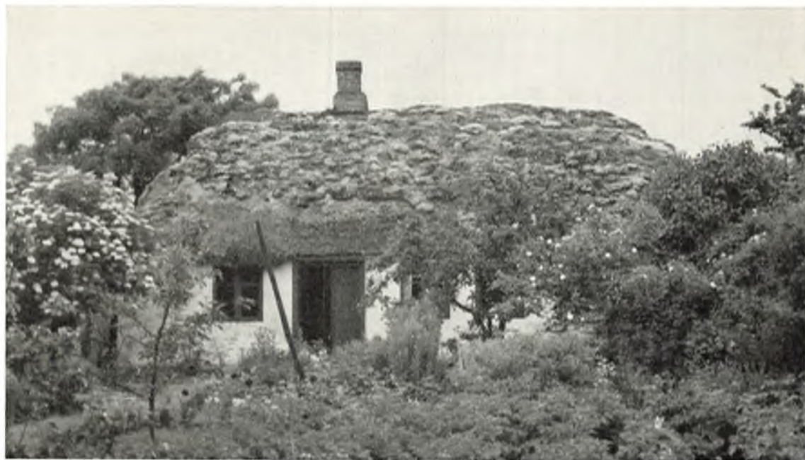
Dette 90 år gamle hus på Endelave er dækket af det sidste tangtag på øen. Tangen er løst ophobet og ikke bundet fast til lægterne som materialet i de normale stråtage. (Fot. 1952 Peter Michelsen).
