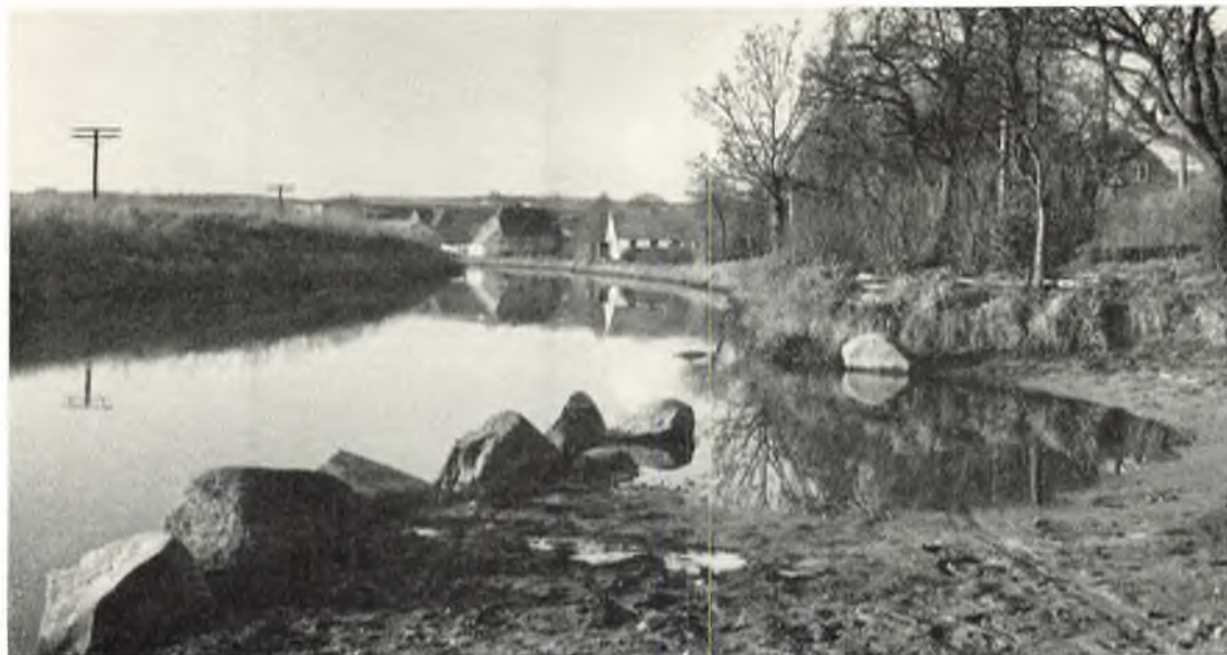
Parti fra Ginnerup ved Kolindsund med en del af randkanalen, der tjener til opsamling af overfladevandet fra højderne omkring. Bag dæmningen breder sig det udtørrede Kolindsund. (Fot. W. Øvlesen).
