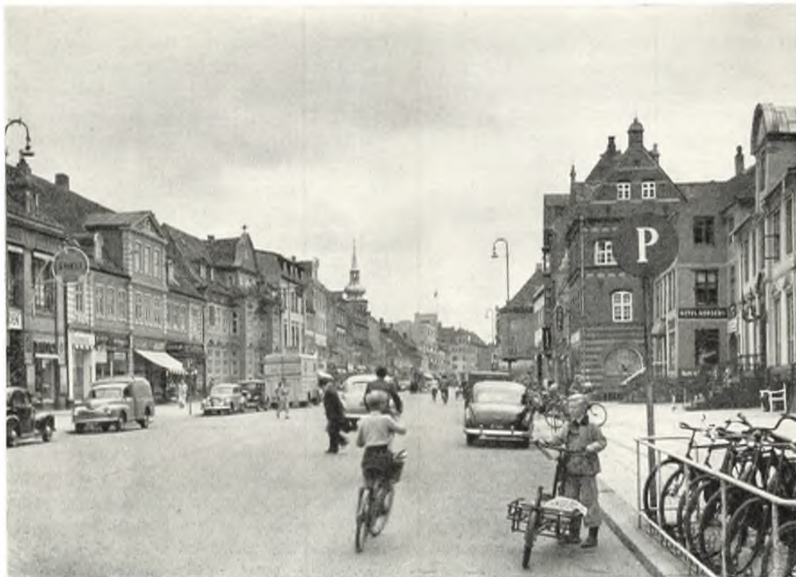
Søndergade i dag set fra samme sted som foregående billede. I gades højre side er Claus Cortsens gård forsvundet, mens apoteket med sin karakteristiske trappe er bevaret. I venstre side er den Lichtenbergske gård, nu Jørgensens Hotel, og det fine hus t. v. herfor i det væsentlige urørt. (Fot. 1953 N. Elswing.)
