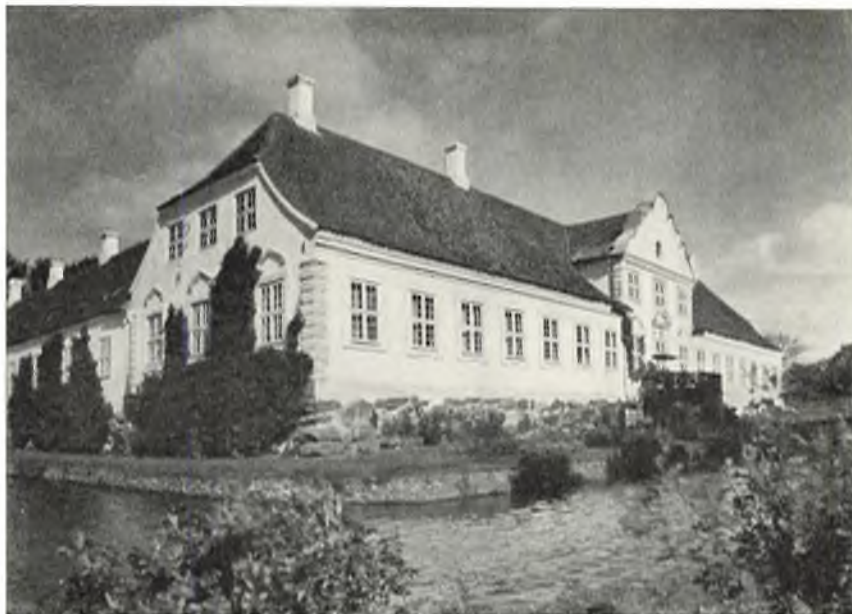
Gisinggaard, set fra syd- øst. Den smukke barokho- vedbygning er opført 1747 af Hans Folsach, af den slægt, som endnu besidder gården. De to sidefløje var oprindelig af bindings- værk, men er senere blevet skalmuret. (Fot. Holt og Madsen).
