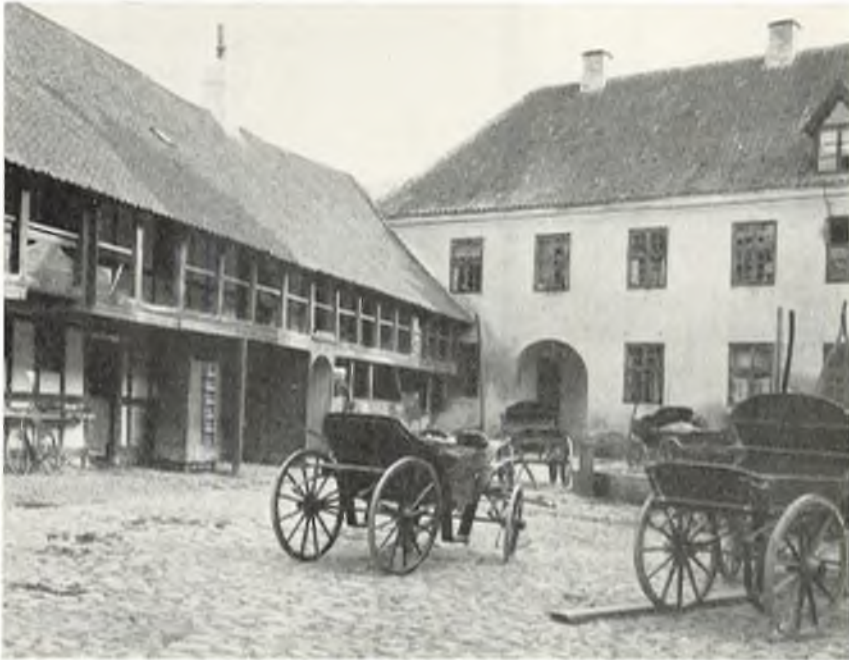
Gammel købmandsgård ved Adelgade. Købmandsgården Adelgade 73 består af en grundmuret hovedbygning til gaden, bygget efter en brand i 1812. Bygningen er blandt byens største. Hertil slutter sig en sidelænge af bindingsværk med svalegang. På gårdspladsen holder bøndervogne fra omegnen. (Fot. 1919 Hugo Matthiessen).
