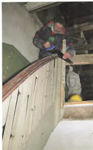
Ejvind Maltesen er i gang med at afmontere trappen i trappeopgangen.
