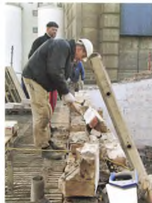
Bendix Weiss viser her folkene fra nedbrydningsfirmaet, hvordan stenene løsnes og renses for mørtel.
