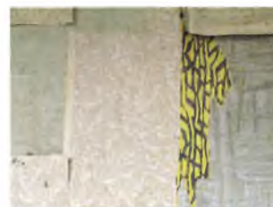
Undersøgelsen af tapet- og farvelag viser her fra venstre mod højre en grå farve på den pudsede væg efterfulgt af tre forskellige tapeter.
