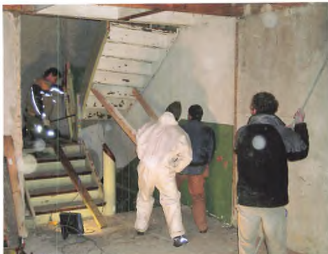
Trappen kunne skilles ad i hele løb, og bliver derfor lettere at samle i sin helhed, når bygningen skal genrejses. Thomas Bordal, Gert Rasmussen og Lars Jacobsen løsner og støtter trappen, mens Ejvind Maltesen holder igen med et tou.
