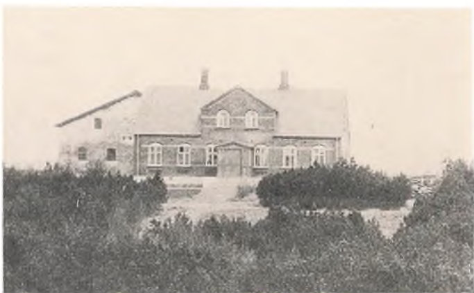
Den nye tids bondegård. Til æsteternes skræk brød man næsten helt med de gamle danske byggetraditioner. Stråtaget, de hjemmebrændte teglsten og de afvalmede gavle er forsvundet, skifertag og teglværkssten i helt ny byggestil er trådt i stedet. Det skal kunne ses, at her bor den nye tids bonde. »Sejlstedlund«, Gjesing by, Bryndum sogn, bygget 1908 for landstingsmand Gregers P. Gregersen, der i 1890 havde anlagt plantningen på stedet. Foto 1912.
