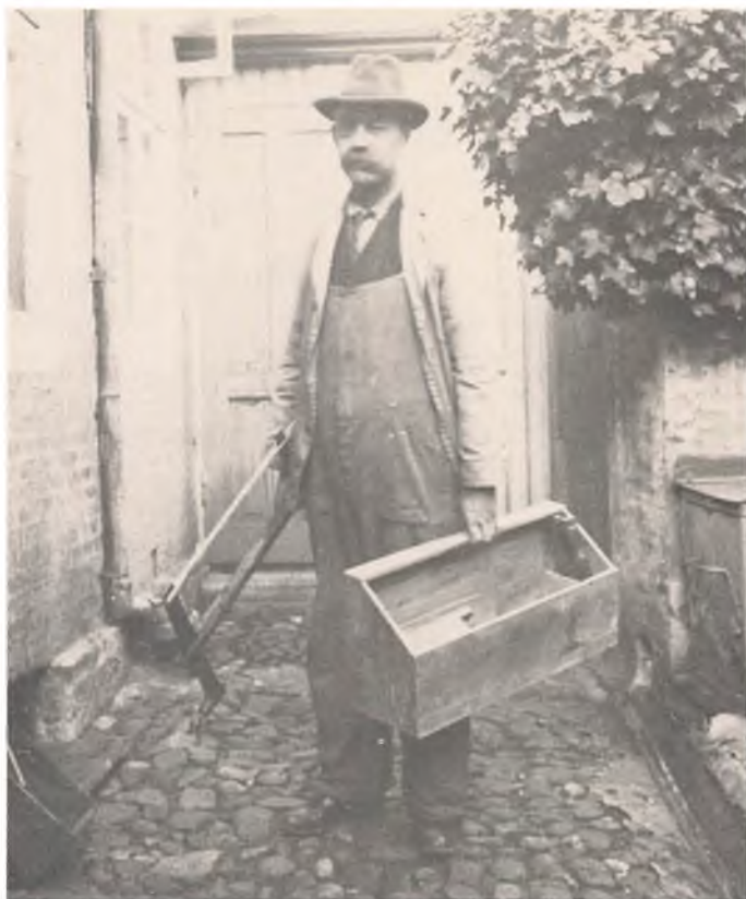
Den smalle, brolagte gård bag Torvegade 3. Læg mærke til afløbsrenderne af træ. Bag på fotografiet har Håkonson skrevet: »Hurtig Udrykning, der er Penge at tjene - - - det er kun smaa Job, jeg har haft 1½ og 2 Uger«. Formentlig er billedet fra tiden efter 1930, hvor hans fagforeningsbog røber en del arbejdsløshed.
