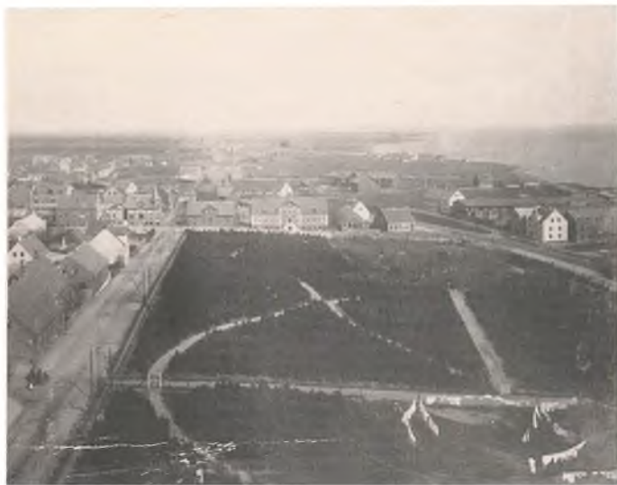
Udsigt fra vandtårnet mod øst ca. 1900. »Anlægget«, der nu hedder Byparken, er helt nyplantet. Pavillonen er ikke bygget, kvarterets beboere har tørreplads på stedet. I Englandsgade, midt i billedet, den ret store bygning, som endnu er bevaret. Efter sigende skal der engang have været emigranthotel dér. Lidt længere tilbage ses det ældste sygehus, hvor der nu er fabrik for chokolademælk. Helt i billedets baggrund ses de store teglværker, ligesom man kan se »Østre badeanstalt« med badebroer.
