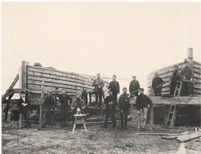
To træskibe under bygning på Th. Dahls skibsværft i Esbjerg, ca. 1898.
