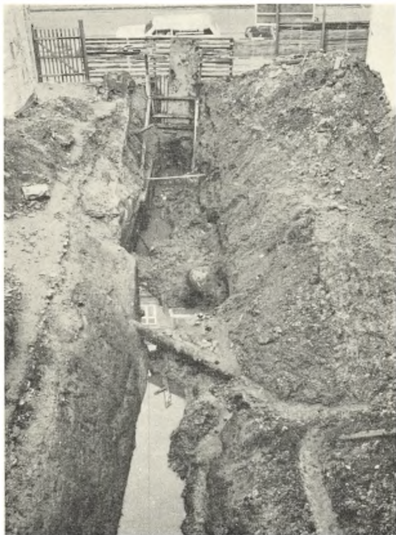
Fig. 1. Den vandfyldte udgravning fra syd. I mellemgrunden en trævandledning. Bagved ses den store sten ved bolværket. Nordligst skimtes, under afstivningen, tømmer fra mølledæmningen. I baggrunden Løngangsstræde
