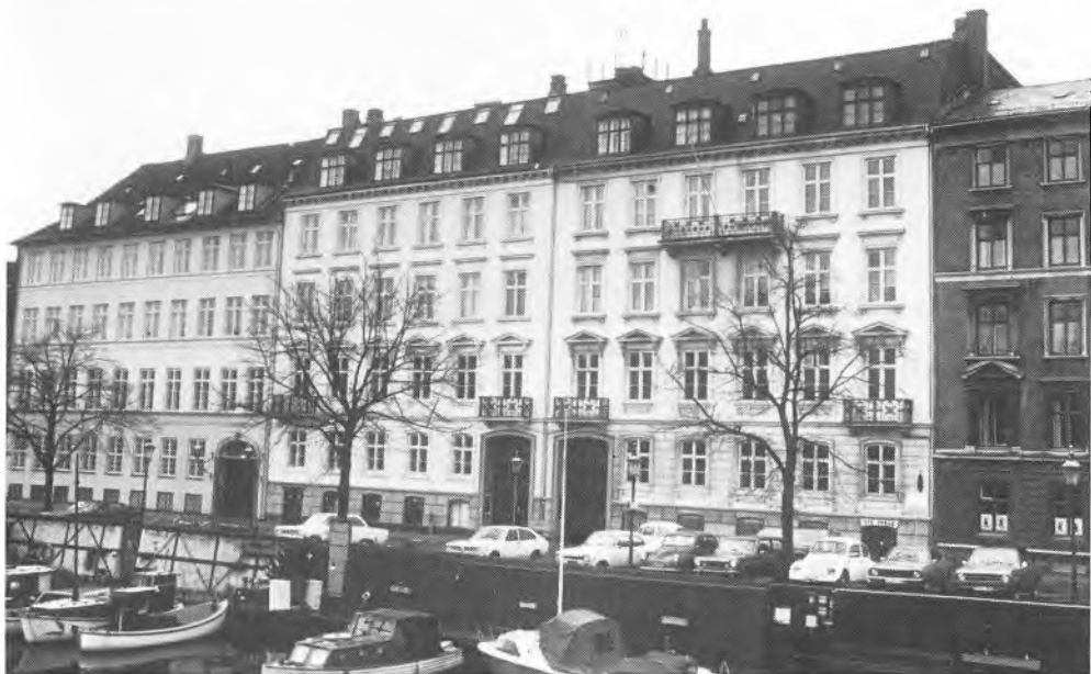
Frederiksholms Kanal 16-18. Omkring 1850 begyndte skifer og zink at komme i brug som tagdækningsmaterialer. De tillod andre tagformer og hermed højere udnyttelse af tagetagen. Almindeligt blev således en art mansardtag med en stejl front af skifer og en næsten flad midterste del af zink. Erik Hansen 1977.
