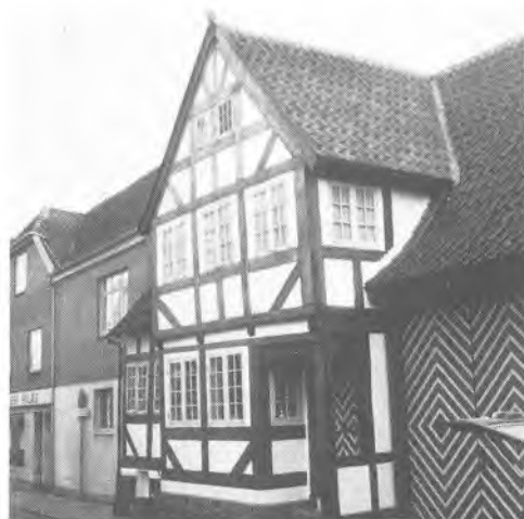
Bagergade 1. Den karakteristiske karnapkvist har inden for de seneste år fået retableret vinduerne i underetagen, hvor der tidligere var bagerbutik. Fot. Allan Tønnesen 1977.
