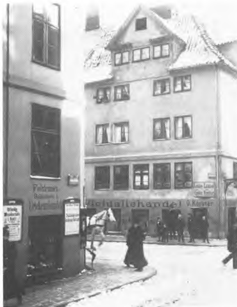
Fiolstræde 18. Før og efter den noget romantiserede fremdragelse af bindingsværkets tømmer. Også i den overpudsede udgave afslører bygningen sig som et bindingsværkshus ved den ringe afstand, en stolpebredde, mellem vinduerne.
