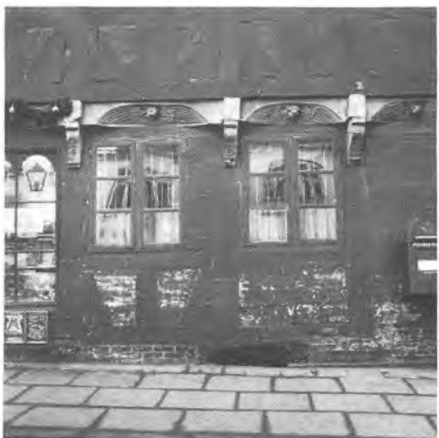
Algade 2. Udsnit af facaden, der bl.a. viser skråbåndene, der helt udfylder hjørnerne mellem fodrem og stolper. Fot. Allan Tønnesen 1977.
