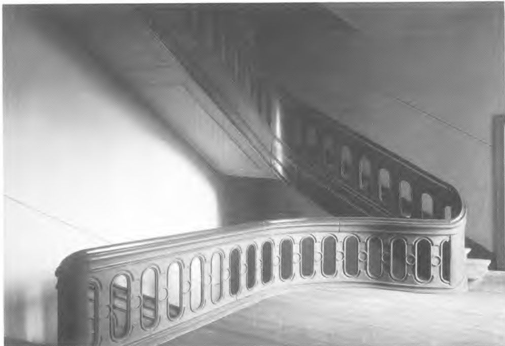
Amaliegade 25. Hovedtrappen med rokokoens karakteristiske gennembrudte balusterværk med de udskårne slyngede bånd (entrelacs). En del af husets oprindelige store sal er nu inddraget til det umotiveret store trapperum. Fot. Hude 1913.
