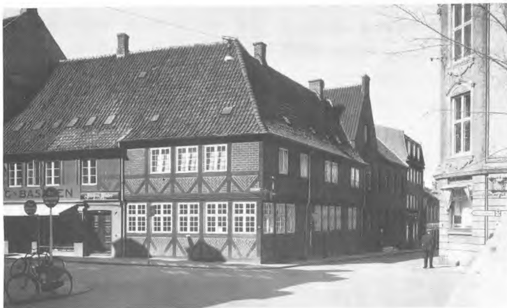
Langgade 2. Czarens hus bærer endnu præg af restaureringen i 1898, der næsten lidt for grundigt rettede op på det gamle hus' skævheder.
