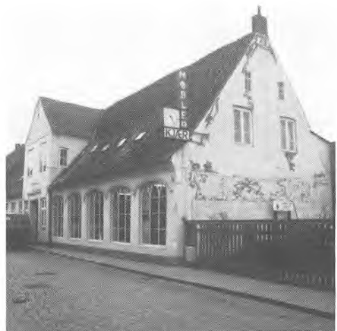
Slotsgade 24. Borgmester Christian Kamphöveners store gård, opført 1765-66. I husets højre halvdel ses jernstøber Stallknechts store udstillingsvinduer. Fot. Allan Tønnesen 1976.
