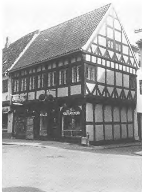
Stengade 20. En af Helsingørs mest markante renaissancebygninger fra bindingsværksarkitekturens glanstid, da udkragning og udskårne konsoller dominerede.
