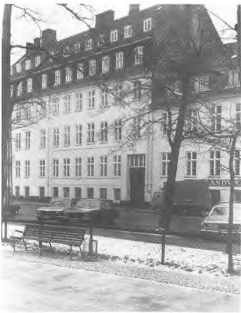
Esplanaden 34. Mens nr. 34 er blevet forhøjet med såvel en ekstra etage som mansard, har tømmermester Hallanders andet hus, nr. 32, bevaret den oprindelige højde.
