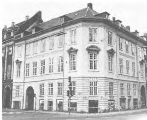
Kronprinsessegade 2. De tre fag på hjørnet kan opfattes som midtpartiet af een lang facade, samtidig med at de to gadesider er udformet som selvstændige enheder.
