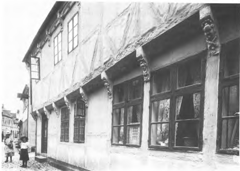
Frisegade 1. Renæssancelængen mod Store Kirkestræde, da den endnu stod ensartet hvidkalket, og de mange lag kalk delvis skjulte overgangsfodens udskårne rankeslyng. Fot. Hude ca. 1900.
