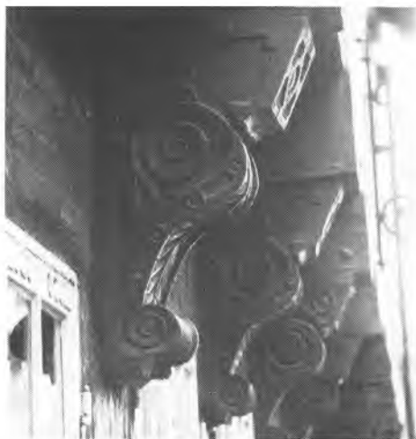
Nørregade 4. Det øvre stokværk understøttes af volutsvungne konsolknægte udskåret med akantusblade og kasetteværk.
