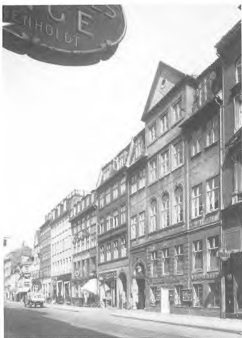
Gothersgade 8. Baron Boltens gård, fotograferet før den lave stueetage som i naboejendommene blev omdannet til fodgængerpassage. Fot. Victor Hermansen 1940.
