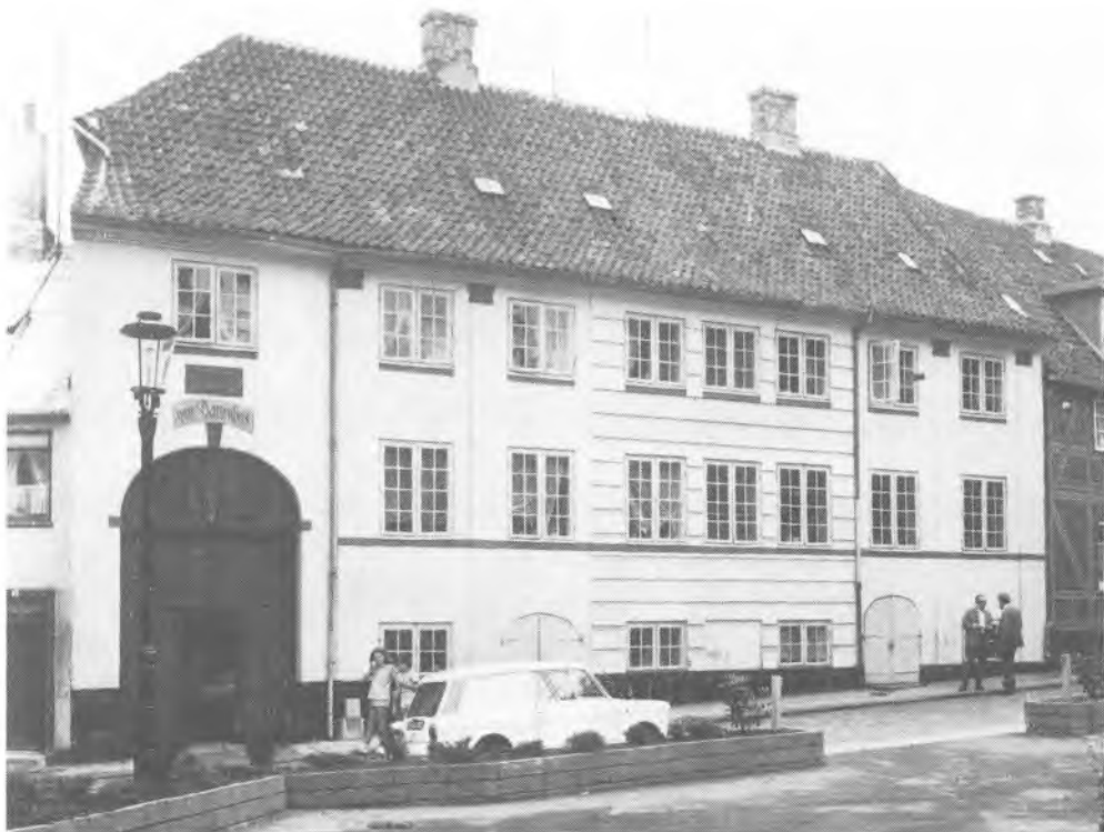
von Hattenstræde 7. Smedemester Busse har antagelig opført sin store ejendom fra 1799 med henblik på udlejning til standspersoner. Bygningen svarer i sine proportioner til amtmændens gård, Middelgade 2. Fot. Hans Henrik Engqvist 1971.
