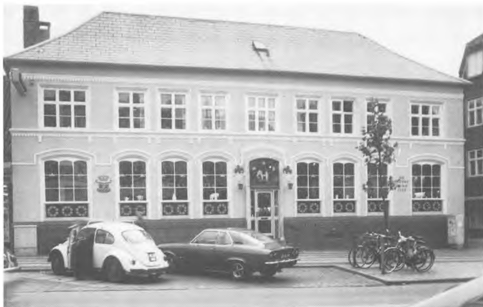
Algade 32. Elefantapotekets facade røber ikke, at husets kerne er en bindingsværksbygning fra o. 1600. Efter en istandsættelse står facaden nu som den så ud efter ombygningen i 1847–48, bortset fra, at der op til indgangen førte en dobbeltløbet trappe. Fot. Allan Tønnesen 1977.
