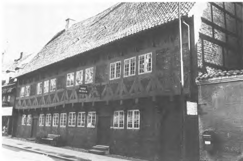
Nørregade 4. Søren Jensens dobbeltgård opførtes i to etager, ældst, fra ca. 1610–15, er den halvdel, der er tættest på beskueren, og som giver sig til kende ved sin rette overgangsfod.
