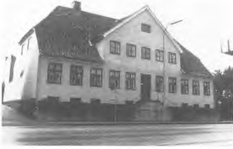
Frederiksværksgade 23. Terrænstigningen betinger den imponerende rejsning, der kendetegner dette typiske Hillerøds hus. Fot. Mogens Kristensen 1977.
