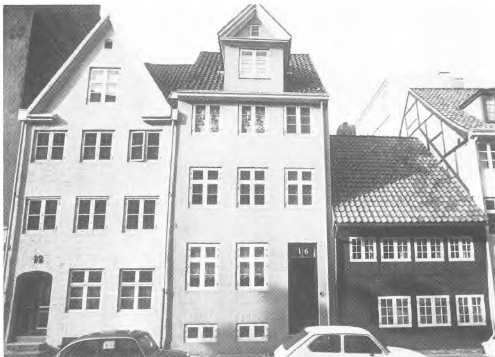
Sankt Annægade 14-18. Johan Lauridsens bod ses yderst til højre. Nr. 16 og 18 hørte oprindeligt også med til boderækken, men har senere fået nye bygninger. Facadebredden viser dog de to ejendommers oprindelse som dele af en ensartet opdelt bebyggelse. Fot. Lars-Kristian Crone 1978.
