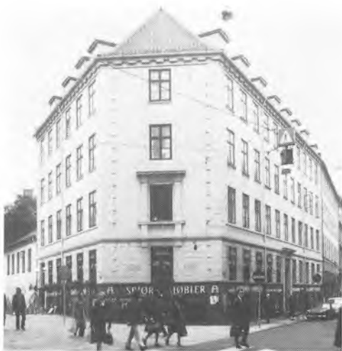
Skindergade 32. Ved en kraftig beskæring af det meget spidse hjørne har Thomas Blom kunnet udnytte gavlens monumentalt som hovedfacade mod et lille torv. Fot. Allan Tønnesen 1971.
