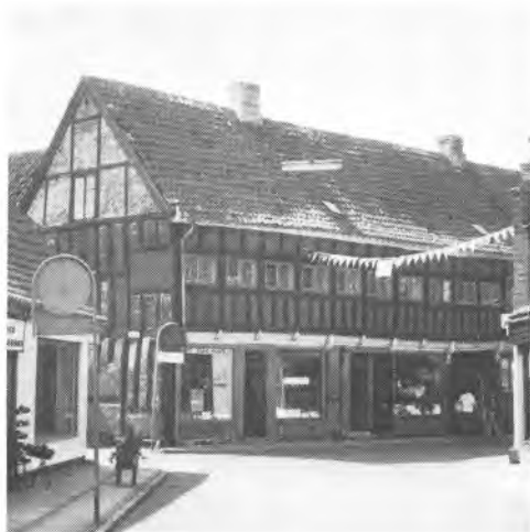
Algade 31. I den grundmurede underfacade er der uden sammenhæng med bindingsværkets struktur anbragt døre og butiksvinduer. Fot. Allan Tønnesen 1977.
