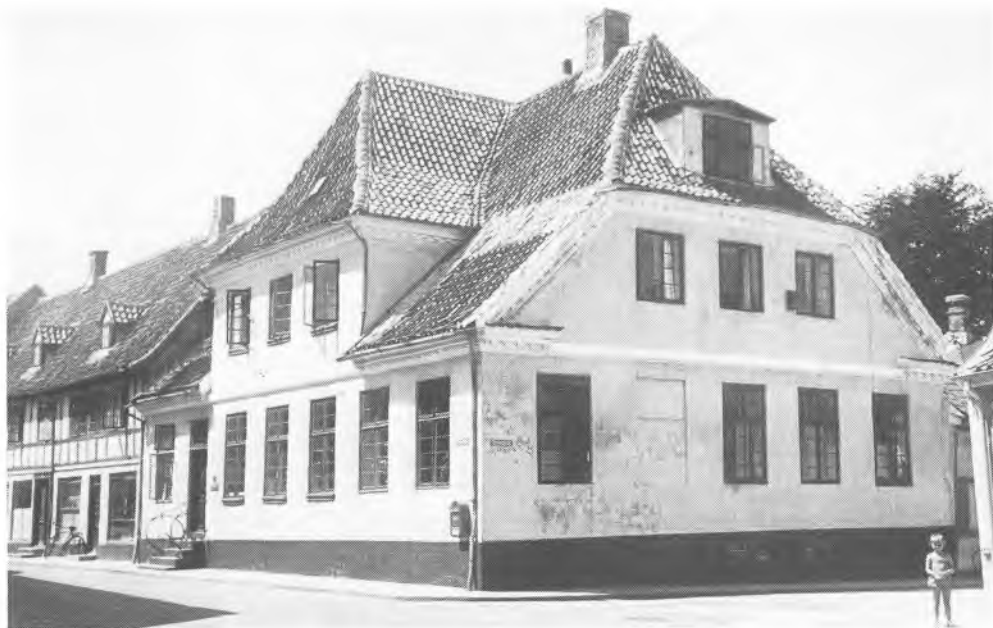
Nørregade 21. Rudkøbings første grundmurede bygning kom ved en mærkelig skæbnens tilskikkelse til at huse skiftende borgmestre og deres enker gennem hele den lange periode fra 1815 til 1891. Ældre fotografi.
