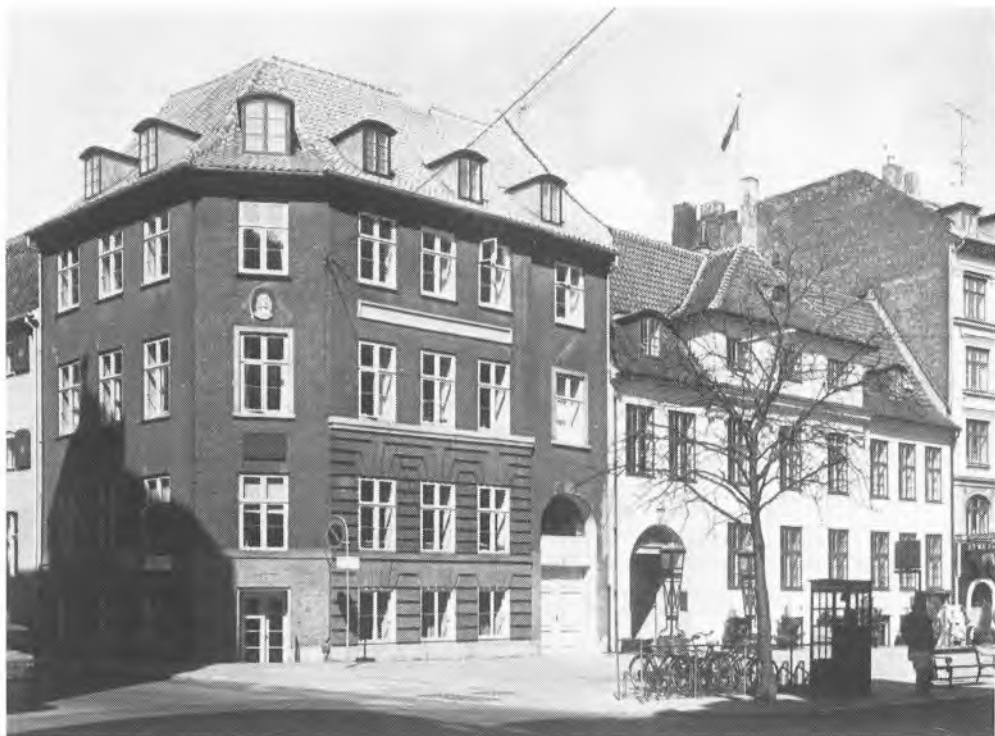
Vandkunsten, det lille torv, hvor der i middelalderen var mølledam. Huset på hjørnet af Gåsegade er nr. 10, C. H. Ordings bryggergård fra 1803. Til højre ses nr. 8, endnu en bryggergård, opført ca. 1750 og ombygget i begyndelsen af 1800-tallet. Fot. Lars-Kristian Crone 1978.
