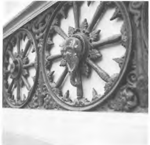
Algade 32. Elefanten er det gennemgående motiv på apotekets i 1847-48 moderniserede facade, her på støbejernsdekorationerne under vinduerne. Fot. Allan Tønnesen 1977.
