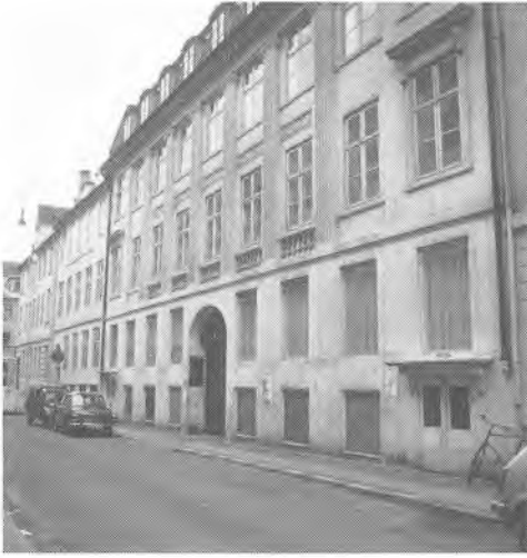
Badstuestræde 18. Dækpladerne på konsollerne over kældernedgangene er af sandsten, men kaldes »skure«, antagelig som et levn fra den tid, da sådanne af-dækninger virkelig var af træ. Fot. Allan Tønnesen 1978.
