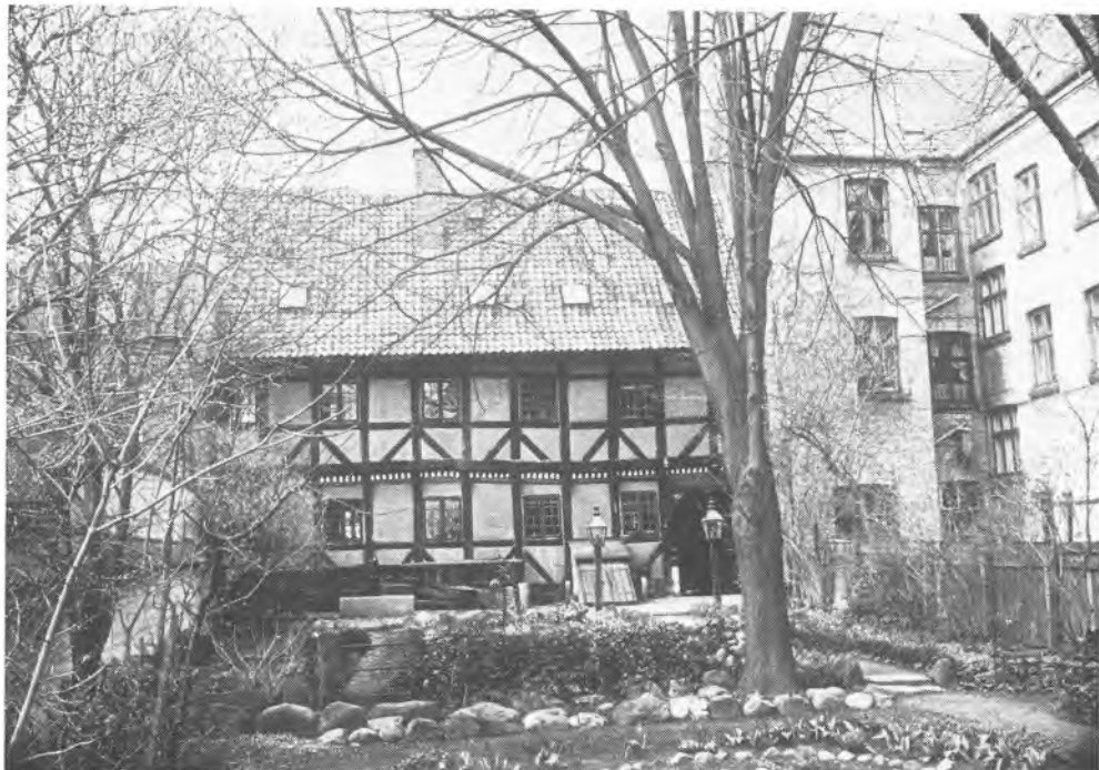
Langebade 8. Karsten Iversens gård er opført i 1630 på en tid, hvor også bagsiden fik udkrøgning, i modsætning til den ældre højstolpekonstruktion, som er almindeligst i 1500-tallet. Fot. Mogens Kristensen 1978.
