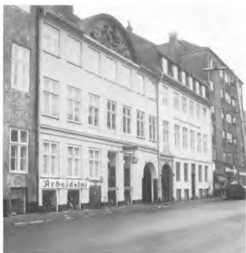
Strandgade 22-24. Cort Adellers gård omfattende begge de nuværende lyse ejendomme, der opstod efter en deling i 1700-tallet. Fot. Allan Tønnesen 1978.
