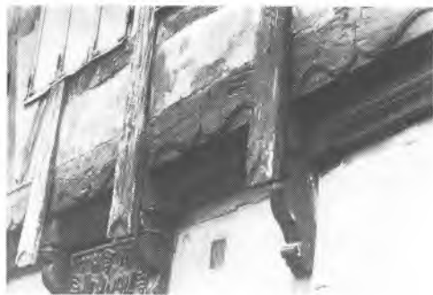
Detalje af apotekets bindingsværkslænge mod Færgestræde. Kølbuen, der afsluttes af et kors, er et ofte forekommende træk i Helsingør. Bemærk stolpeskællene, der dækker bjælkehovederne. Fot. Mogens Kristensen 1978.
