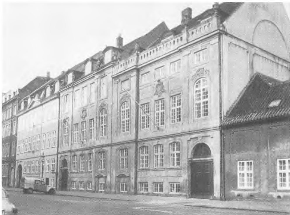
Amaliegade 15-17. Pfeiffers og Bæsekes gårde. Balustraden på nr. 17 skal tænkes ført igennem over hele dobbeltgårdens facade. Ved forhøjelsen har nr. 15 bevaret sandstensvaserne, der er flyttet op på den nye hovedgesims. Fot. Allan Tønnesen 1978.
