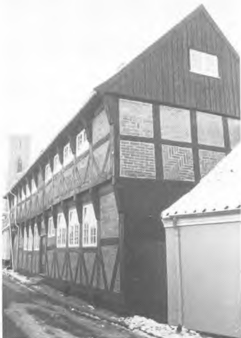
Præstegade 15. Den af Ribe by i 1576 opførte bolig for domkirkens kapellan lå ikke ved et af byens hovedstrøg, hvor jorden var knap, og kunne derfor opføres som et langhus med siden til gaden. Fot. i Antikvarisk Samling, Ribe.
