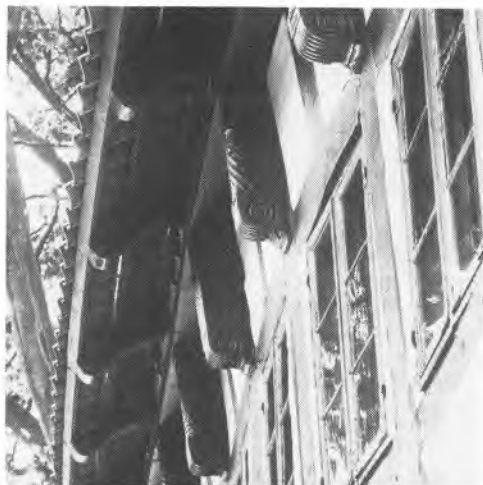
Nørregade 31. Karakteristisk eksempel på »Køgeknægte«, tagskægsknægte, der dels understøtter tagfoden, dels skjuler bjælkehovederne. Fot. Mogens Kristensen 1977.
