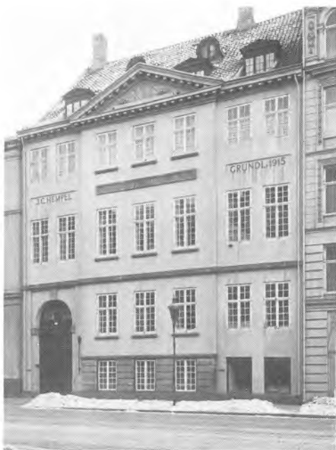
Amaliegade 8. Pfütznerns gård. Førstesalen er klart markeret som beletage, husets fornemste, ved at være to ruder højere end de andre etager. Fot. Victor Hermansen 1941.
