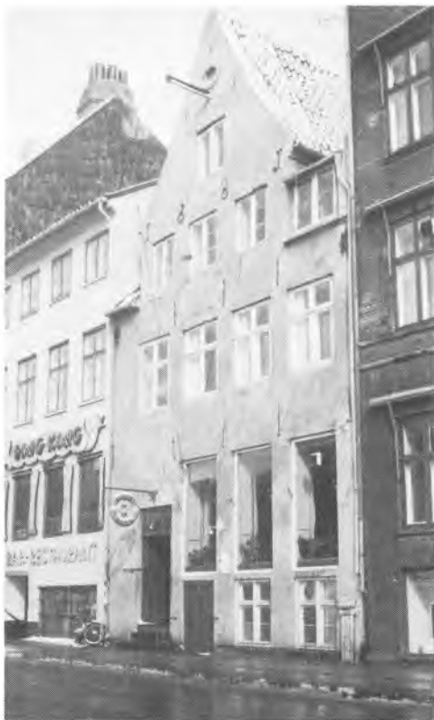
Nyhavn 9. Det velbevarede lille gavlkvisthus har endnu sin hejsebom, omend det oprindelige stykke tømmer er udskiftet med en jernbjælke. Fot. Allan Tønnesen 1978.
