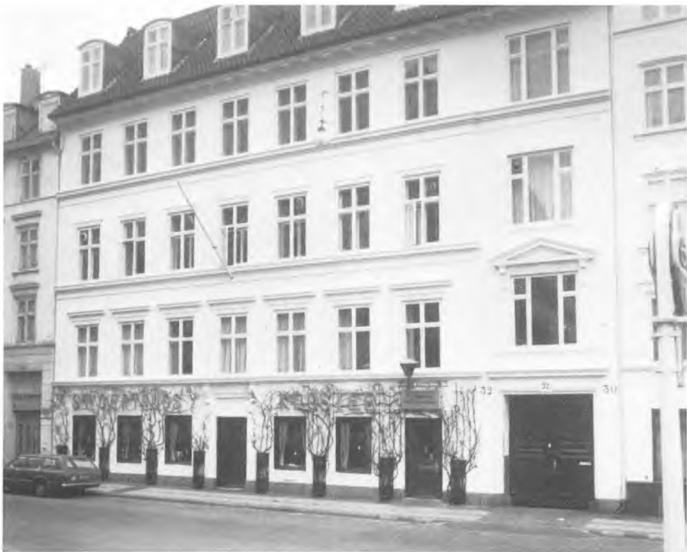
Hauserplads 32. Det senere tilføjede brede yderfag har forskudt etageinddeling på grund af portgennemkørselen. Stueetagen rummede i mange år et vinfirma, men er nu blevet til restauration. Fot. Allan Tønnesen 1978.
