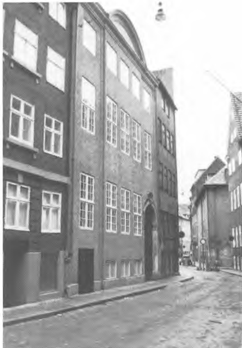
Magstræde 6. Philip de Langes bygning efter en restaurering, der har genskabt den oprindelige facade. Fot. Allan Tønnesen 1977.
