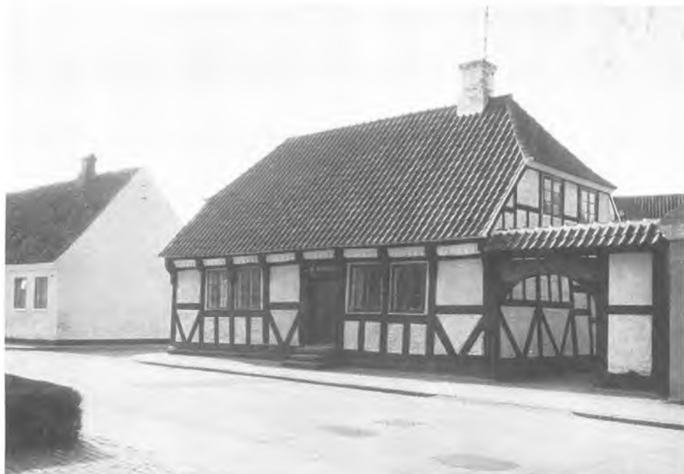
Algade 12. Den beskedne rest af borgmester Hans Grams oprindelig 15 fag lange forhus fra 1624. Vejen, der krævede fjernelse af en del af huset, blev til gengæld benævnt efter den gamle borgmester. Fot. Allan Tønnesen 1978.
