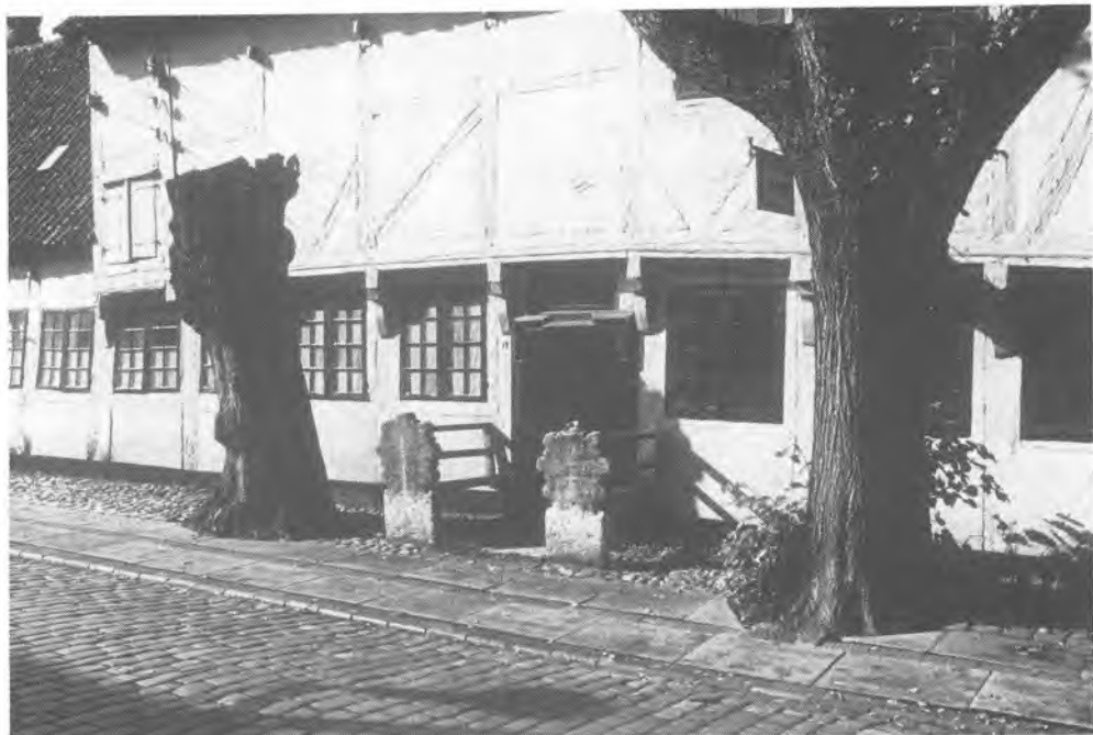
Store Kirkestræde 13. Det eneste bevarede eksempel på et borgerhus med bislagsten ved indgangen. Bygningen selv udmærker sig ved at have bevaret overetagen som magasinloft. Fot. Mogens Kristensen 1977.
