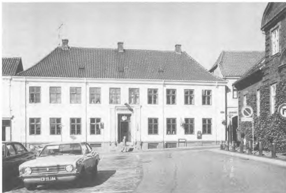
Nytorv 3. Svaneapoteket er egentlig en bindingsværksbygning opført efter Viborgs brand i 1726, der i 1846 fik en ny skalmuret facade. Til højre ses den Friedenreichske gård. Fot. Allan Tønnesen 1976.
