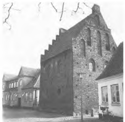
Præstegade 21. Tårnagtigt rejser det middelalderlige stenhus sig mellem de lave købstadshuse. Husets soliditet vidner om sognepræstens position i samfundet.
