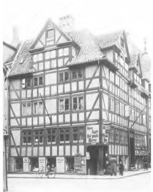
Fiolstræde 18. Før og efter den noget romantiserede fremdragelse af bindingsværkets tømmer. Også i den overpudsede udgave afslører bygningen sig som et bindingsværkshus ved den ringe afstand, en stolpebredde, mellem vinduerne.
