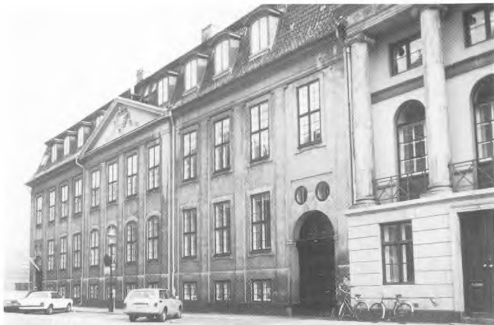
Amaliegade 40-42. Efter Eigveds plan skulle der her og på naboejendommen have ligget et tilbagetrukket palæ med 10 mindre pavilloner ud til gaden, korresponderende med hans projekt til Frederiks Hospital på den anden side af gaden. Jan von Ostens gård opførtes få år efter Eigveds død efter helt ændrede planer. Fot. Allan Tønnesen 1978.
