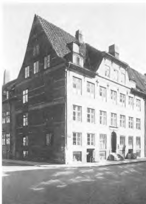
Strandgade 32. En ekstra etage er skudt ind i borg- mester Mikkel Vibes renaissancehus, som har bevaret underste halvdel af sin gavlkvist. Fot. Victor Hermansen 1942.
