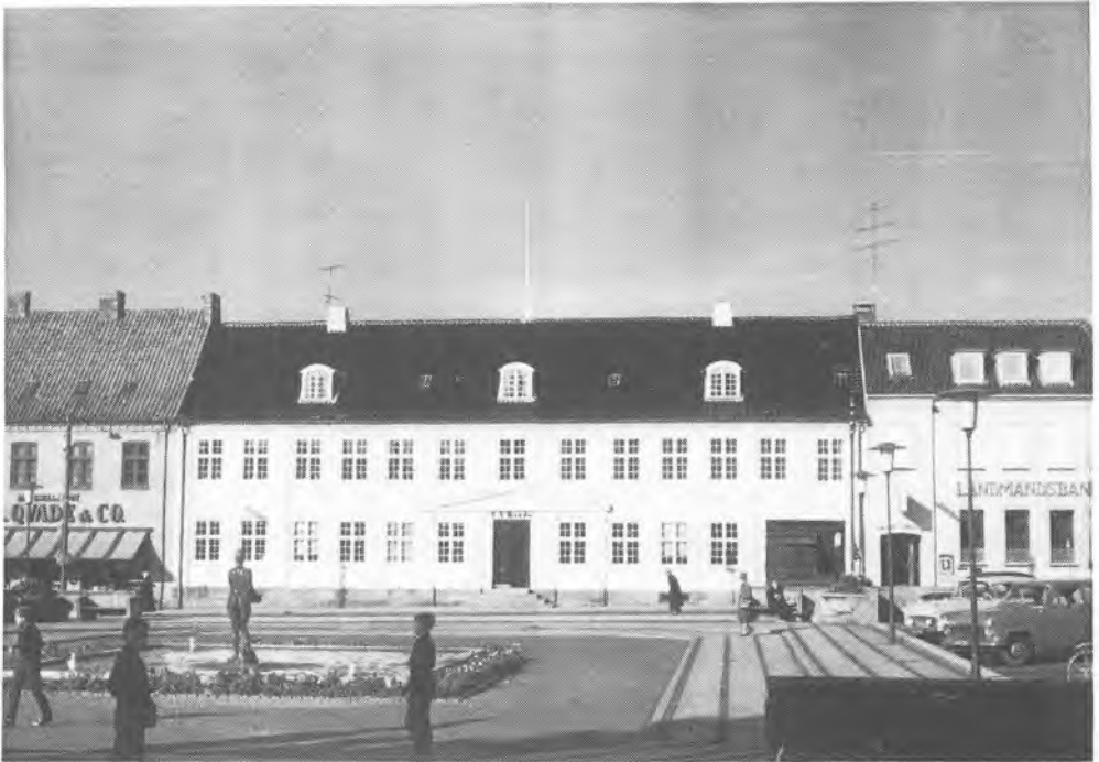
Torvet 3. Da købmandsfirmaet Qvade drev detailhandel i gården var der i en periode butiksvinduer i underetagen. De oprindelige vinduer er nu retableteret. Fot. Flemming Jerk 1961.
