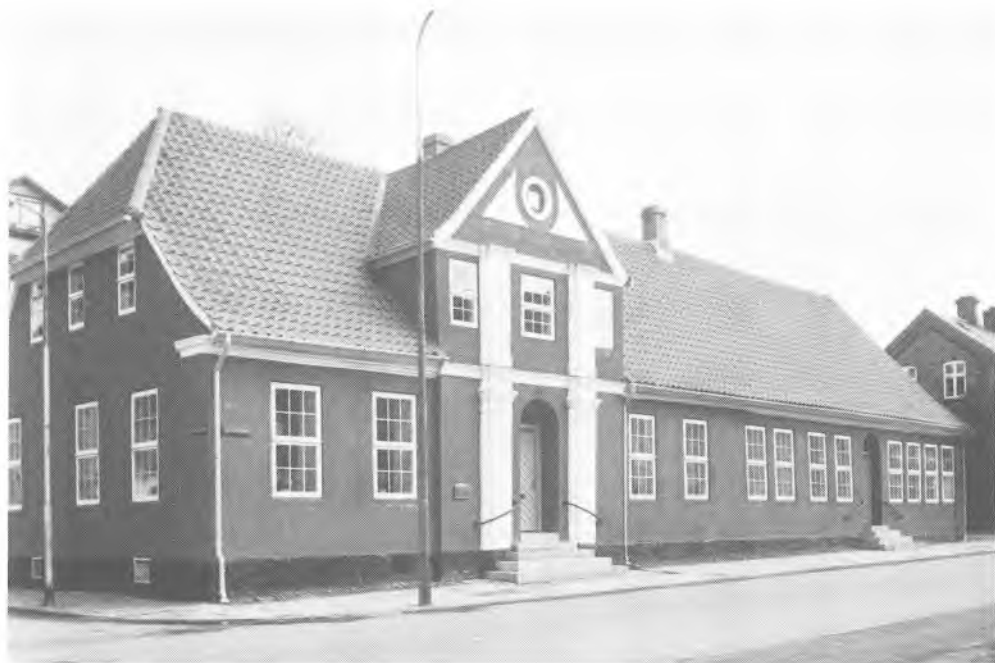
Danmarksgade 61. Alt tyder på, at det er en sønderjysk bygmester, der har ansvaret for provstegården i den skikkelse, den fik o. 1770. Den asymmetrisk placerede kvist med den pilasterprydede portal og vinduernes specielle udformning genfindes f.eks. i Åbenrå. Fot. Allan Tønnesen 1977.
