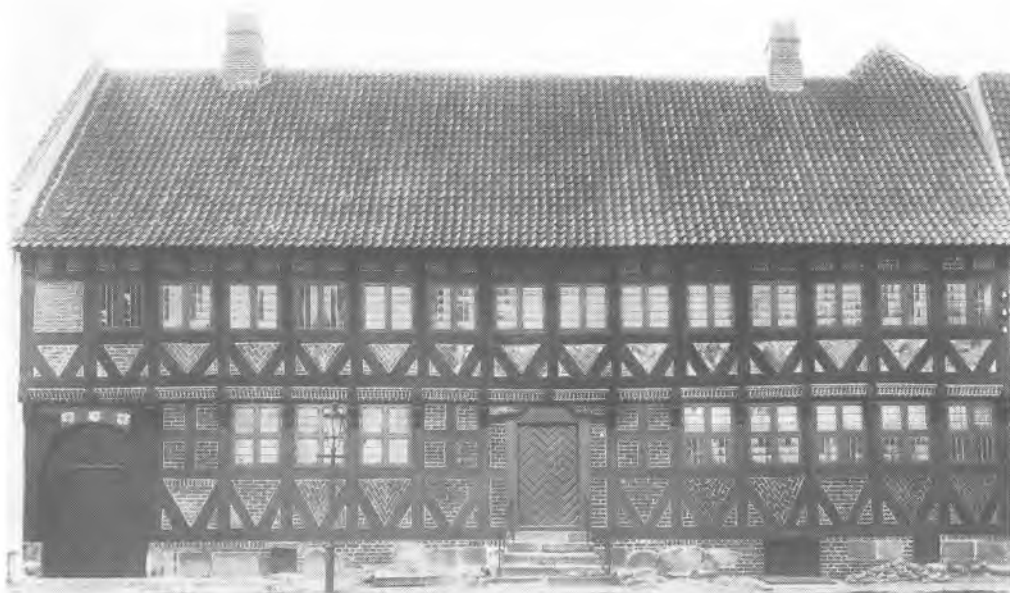
Slotsgade 11. Mads Lerches gård fotograferet kort efter, at bygningen var blevet restaureret i 1916. Man var ikke så bange for rekonstruktion og isatte uvivlsomt korrekt, manglende tømmer og blysprossede vinduer m.m. I dag ville man nok have været mere tilbageholdende. Fot. Erhardt Jensen 1919.
