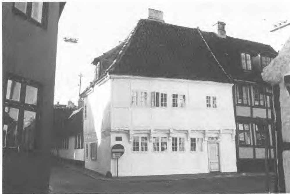
Strandgade 27. Helsingørs ældste daterede bindingsværkshus fra 1577, kaldet Ankeret efter det værtshus, der en gang var her. Såvel gavlen som dennes afvalmede tag stammer fra en afkorting af huset. Fot. Mogens Kristensen 1977.
