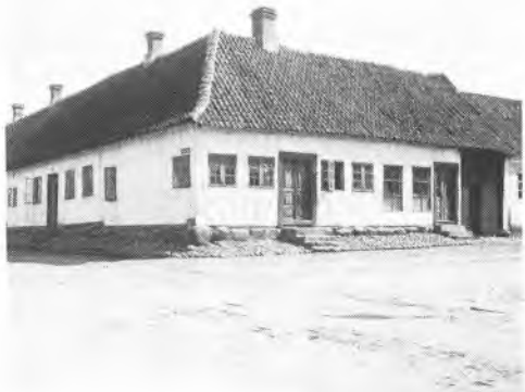
Kongensgade 25. Fredericias ældste hus, hvis utroligt svære bindingsværkstømmer her anes bag hvidtekalken. Huset har i de senere år stået afstolpet. Fot. Hugo Matthiesen 1914.
