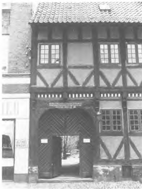
Langebade 8. Den lidt uregelmæssige amorfbue, som portens overligger og skråbånd beskriver, er dekoreret med halvrossetter i sviklerne, et yndet motiv på fynske bindingsværkshuse. Fot. Mogens Kristensen 1978.
