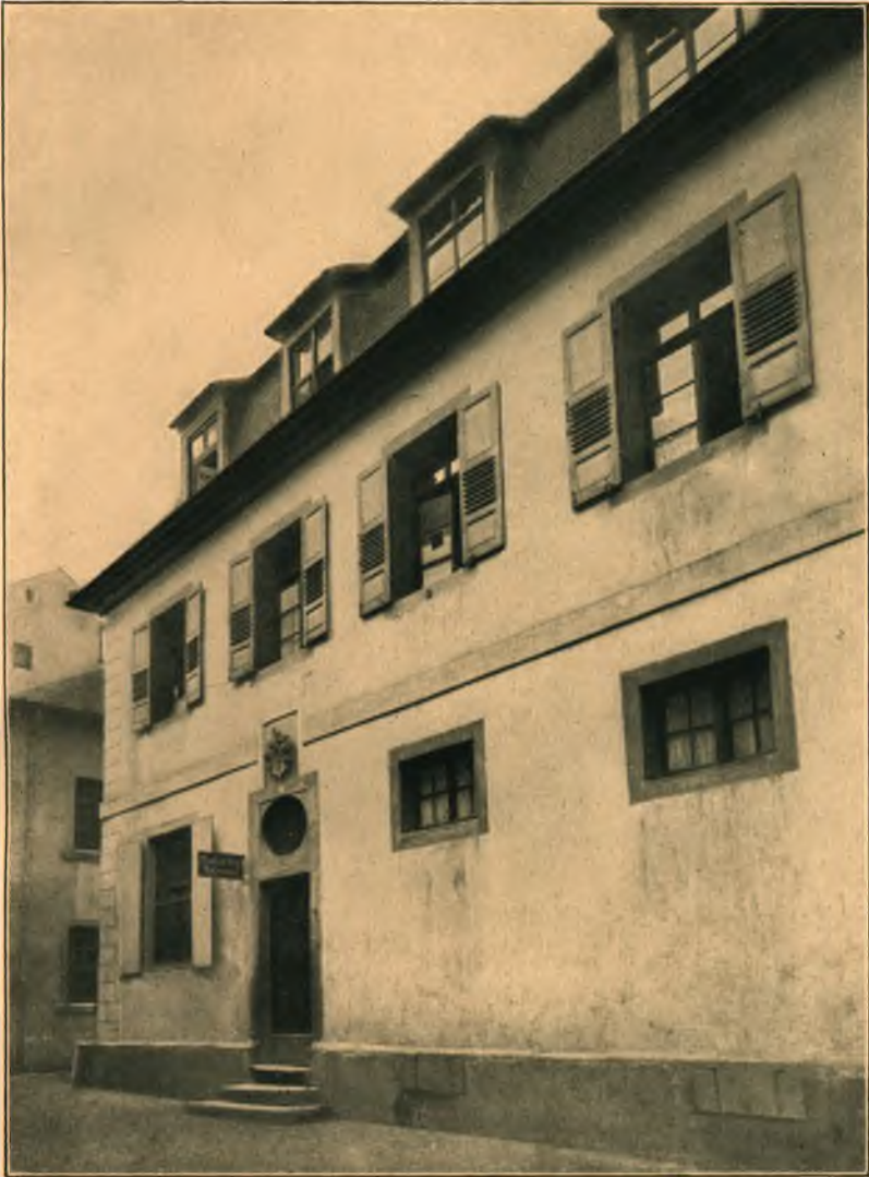
DAS HAUS JÄGERSTRASSE 3 IN DURLACH
