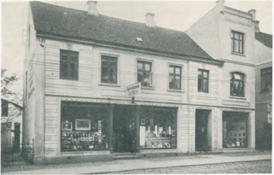
Carl Nielsens ejendom Nørregade nr. 405 c (nu nr. 25) umiddelbart efter erhvervelsen og ombygningen. Gennem indkørslen ses den nye værkstedshygning
