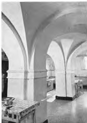
De gamle hvælvinger i kælderen.
