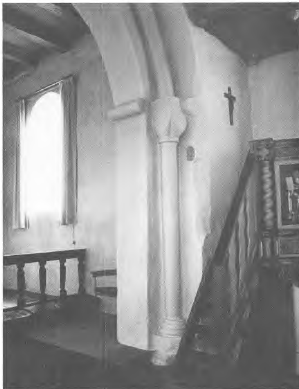
Sydlig del af triumfbuen i Virring kirke. Bemærk det engelsk-normannisk inspirerede søjlekapitel, og det »dråbeformede« fremspring på undersiden af buen. En meget lignende triumfbue findes i Asfjerg kirke nord for Randers (foto Poul Petersen).
