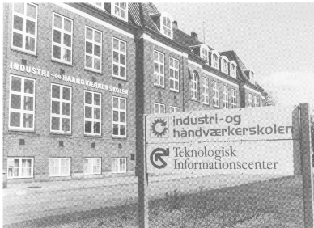
Den gamle sygehusbygning fra 1893, som siden 1959 har været i I & H-skolens besiddelse.
