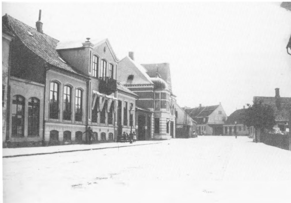
Nykøbings første jernindustrielle virksomhed, Bruunshaab, grundlagt i 1842. Ved århundredskiftet ejedes fabrikken af Karl Bruun.
