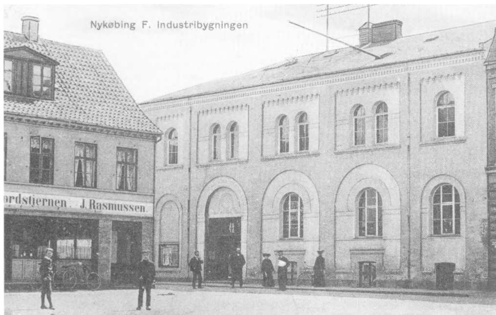
Udstillingsbygningen (eller »Industrbygningen«) set fra Torvet. Til venstre det senere »Risoms Hjørne«, der blev nedrevet i 1936.
