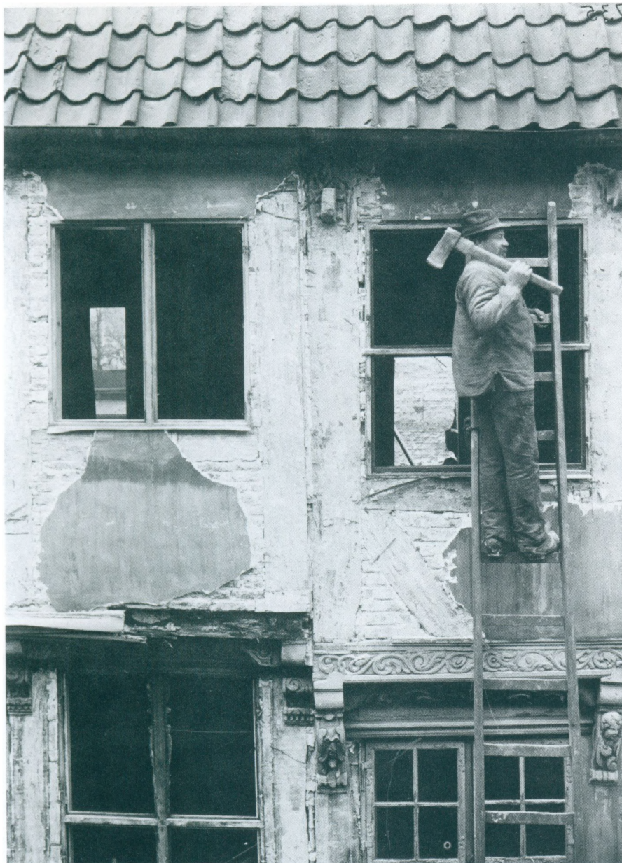
Da nybyggeriet tog fart i slutningen af 1800-årene blev flere fine gamle huse revet ned og erstattet med nye i tidens smag og stil. Her er man i færd med at nedrive »Torskehotellet« i Sct. Annagade. Fot. 1899.
