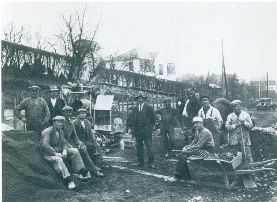
Fra anlæggelsen af Stubbedamsvej, en af de tre ringlinier, som med udgangspunkt ved Rønnebærviadukten og Lappen blev lagt omkring byen i 20'erne og 30'erne.
