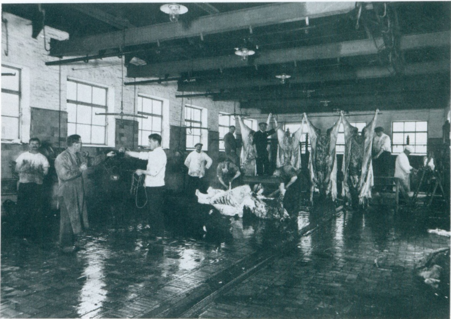
Det offentlige slagtehus i Svingelport omfattede både kreatur- og svineslagtning. En del af slagtehuset, der var opført i 1913–14, blev ved nedlæggelsen i 1939 forbeholdt levnedsmiddelkontrollen, mens resten omdannedes til brandstation. Fot. 1930.
