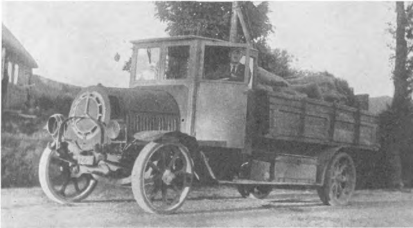
De Dion Bouton Lastvogn. Model 1922. Egenvægt 4140 kg. Lasteevne 4980 kg
