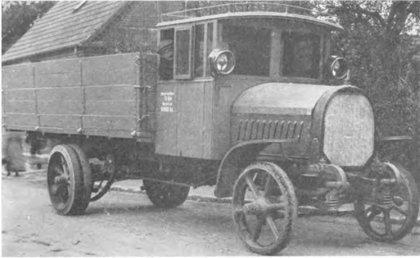
Opel Lastvogn med faste Gummiringe og Kædetræk. Anvendtes ca. 1918
