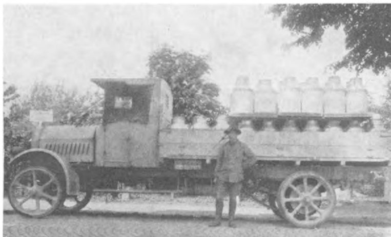
Ældre Model med faste Ringe og Kædetræk
