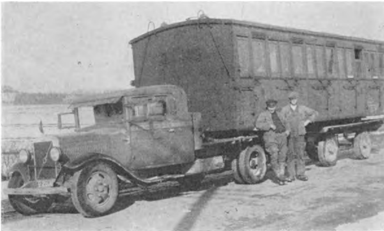
Kasseret Jernbanevogn, som sikkert skal anvendes til Lysthus eller maaske Brændehus, flyttes paa Plads med Lastvogn
