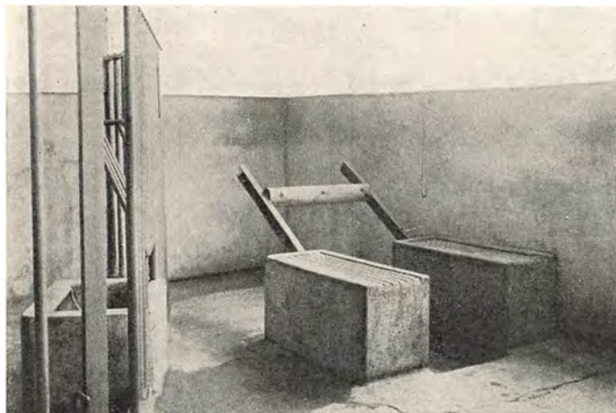
Fig. 57. Bedækningsboks i den nye Favrholtstald. Bestaar af to Betonblokke med riflet Overflade, fortil indstøbt 2 Jernbjælker (H. G. Skovgaard).
