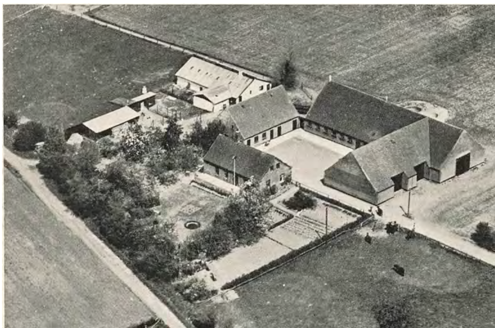
Fig. 45. Løvelændegaard i Lundby, Præstø Amt, ca. 12 ha Ager og ca. 22 ha Eng, tilh. Grd. Hans Larsen. Stuehuset opført 1891, Svinehuset 1914, begge efter Tegning af Haandværkere. De tre store Bygninger opført 1927, Lade og Kostald 13 m bred med Vinkeltag uden Trempel. Disse tre Bygninger af samme Form som de smukke gamle Gaarde. Tegnet af Arkitekt Knud Brücker. Fot. 1938.
