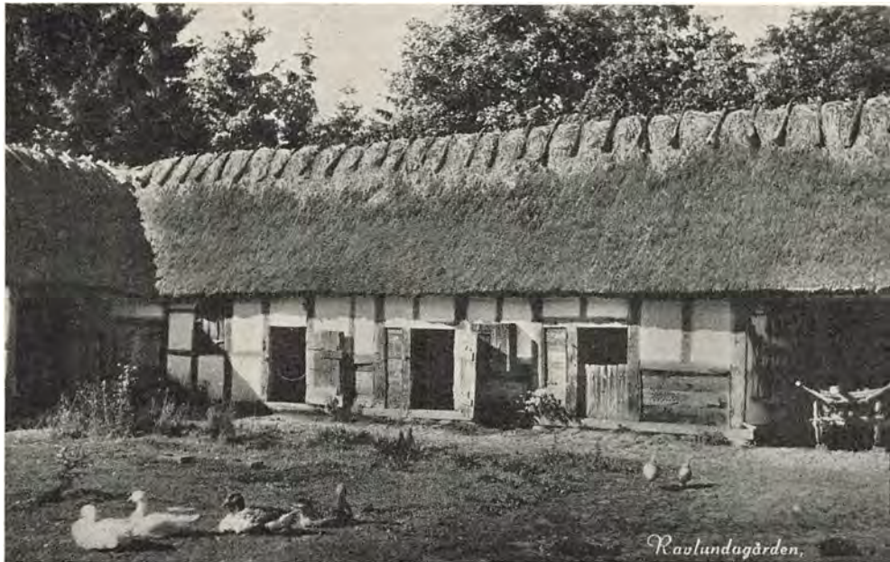
Fig. 67. Ravlundagården fra Skåne , firelænget Gaard, over 300 Aar gammel. Ingen Vinduer i Udhusene, Indgangen til Kostalden er Døren i Hjørnet til venstre i Billedet. Husbredde 4,5 m.
