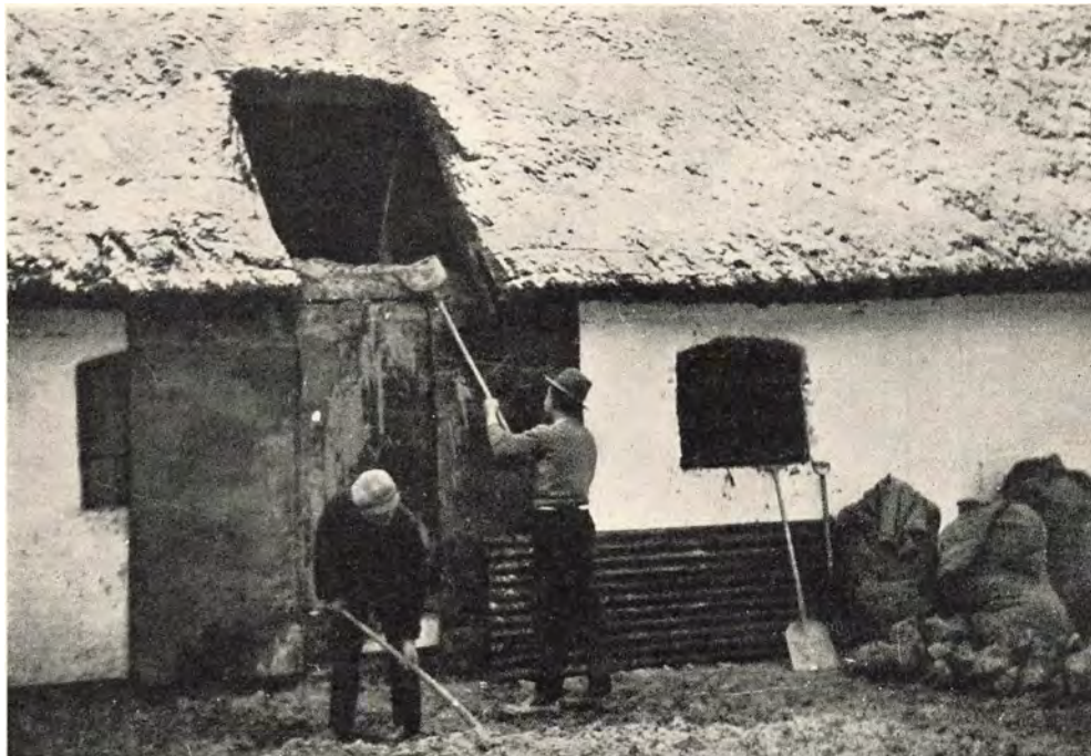
Fig. 104. Leret kastes gennem en Tagluge op paa Loftet over Stalden. Den hvidkalkede Væg er beskyttet ved Opstilling af Vognbunde, Porte eller Jernplader, som senere kan vaskes. Er Lugen højt anbragt bruges en Ladvogn som Mellemed. (Foreningen til Brandbeskyttelse af Dyr.)
