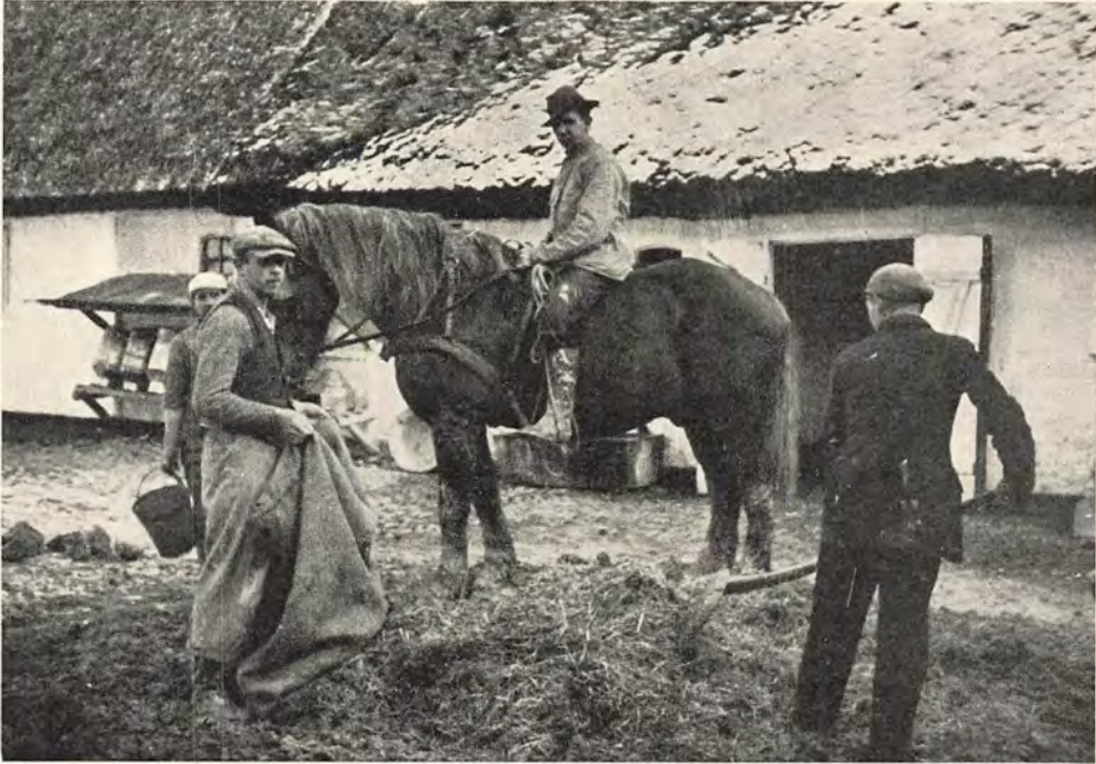
Fig. 103. Æltning af Lerbunken til Lerloftet. De største Lerknolde knuses eller deles med Skovlene, Leret blandes med lidt Avner eller Hakkelse, og der tilsættes Vand samtidig med, at Hesten rides paa Kryds og tværs over Bunken, til hele Massen danner en tyk Grød. Det er vigtigt, at Folkene med Skovle sørger for at vende den tørre Lermasse paa Bunden op, saa den ogsaa bliver gennemvædet og æltet. Ridningen i Bunken kan i Reglen tilendebringes paa 15—20 Minutter. (Foreningen til Brandbeskyttelse af Dyr.)
