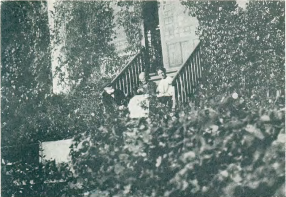
Presteboligen i Frogner (Drammensveien 84).
