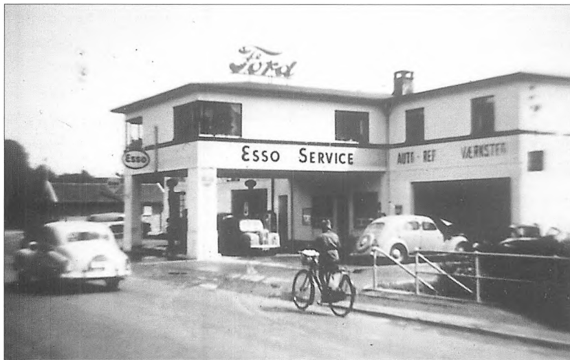
Tankstationen og værkstedet Slotsgade 26.
