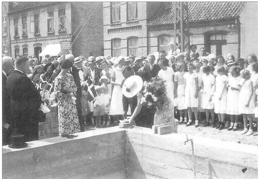
Grundstensnedlæggelse. Kronprinsesse Ingrid murer den første sten.
