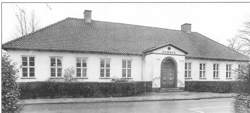
Dommerkontoret i Jernbanegade blev bygget i 1935 som afløsning for lokalerne på slottet.
