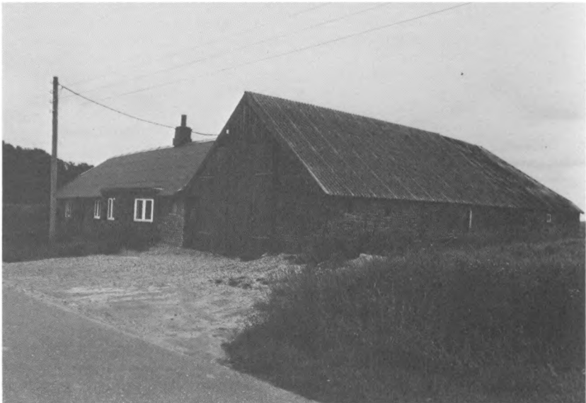
Lille Ellemose, Hygum sogn. Fotograferet i juli 1977 kort efter, at det oprindelige stråtag er blevet erstattet med anden tagdækning.
