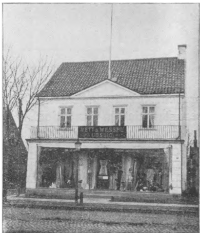
N. Drasbeks forretning, som den nu er.
