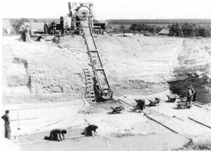
Støbning af bunkersokkel.
