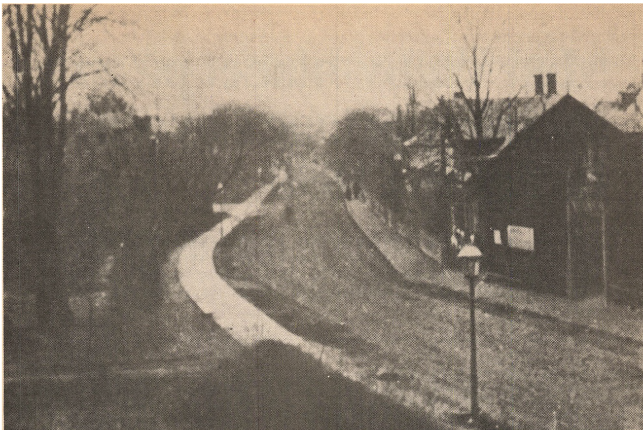
Valby Langgade ud for Jesuskirken i 1898. Det er Korups Have til Højre.
