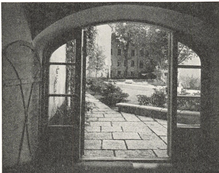
Karreen Cepheus efter Saneringen. Baghusene er nedrevet og erstattet af et Haveanlæg.
