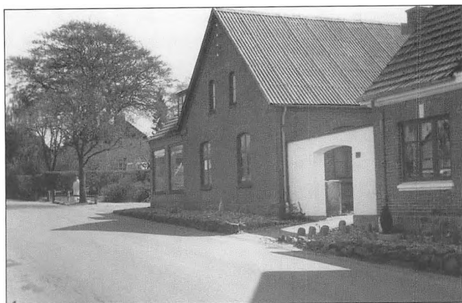
Elektricitetsværket blev bygget på det sted, hvor Paulinesminde oprindeligt lå, Hjarupvej 11.
