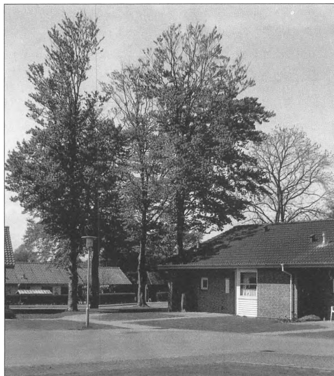
De beskyttede boliger på adressen Lysholm i Vonsild efter at gården er nedlagt og jorden udstykket.
