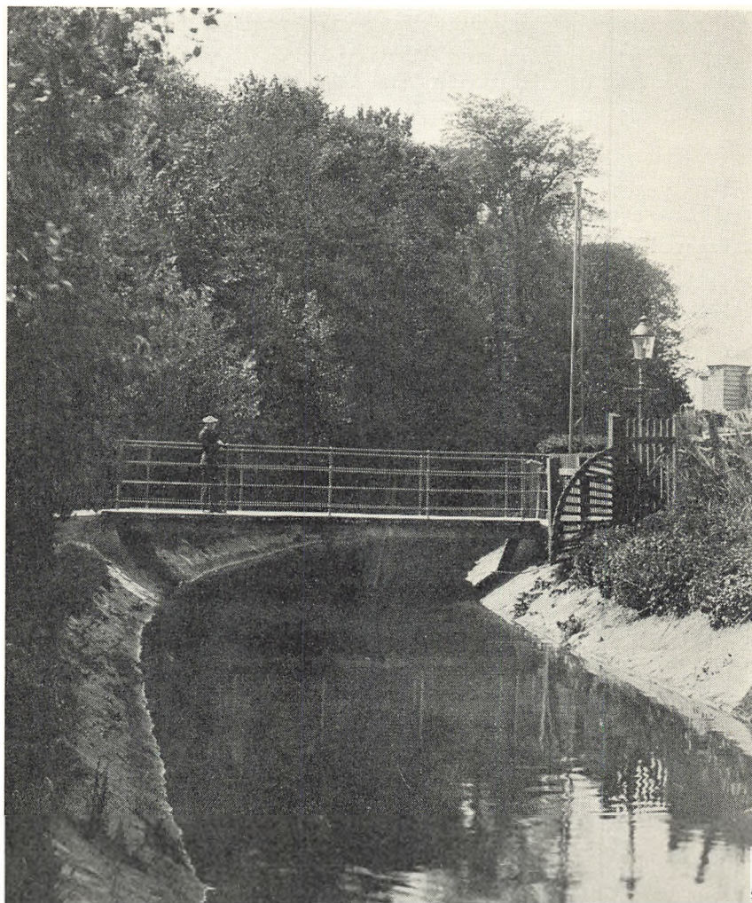
Kanalen med broen fra Langsgade til Karoline- lund, set fra Østerbro, ca. 1910.
