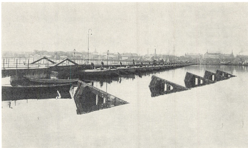
Pontonbroen set fra Nørresundby. De fem tømmerkonstruktioner, der var hamret ned i fjordbundet skulle beskytte broen mod dravis.
