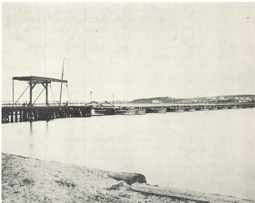
Pontonbroen over Limfjorden mellem Aalborg og Nørresundby. Til venstre er den store færgegalge på Aalborg-siden endnu på plads. 1865.
