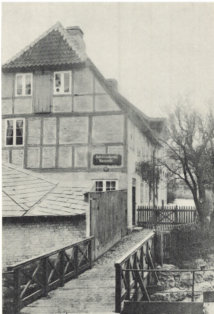
Droen over Østeraa fra Skomagergade til Frederik den Syvendes børneasy, før 1872.
