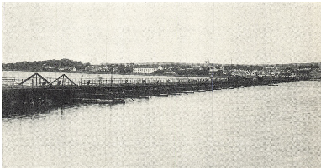
Pontonbroen over Limfjorden set fra Aalborgsiden. Ved de to trætrekanter til venstre i billedet regulerede broen sig efter vandstanden i fjorden.
