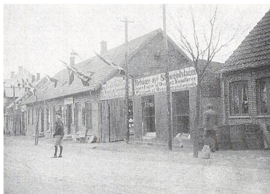
Østergade 18 ca. 1895. I midten ses Helsingør nye Støbøgods-lager, der handlede med kolonialvarer, brændsel, foderstoffer, trælast, cement og støbegods (bl.a. kakkelovne). Butiksløkkerne lå på begge sider af porten.
