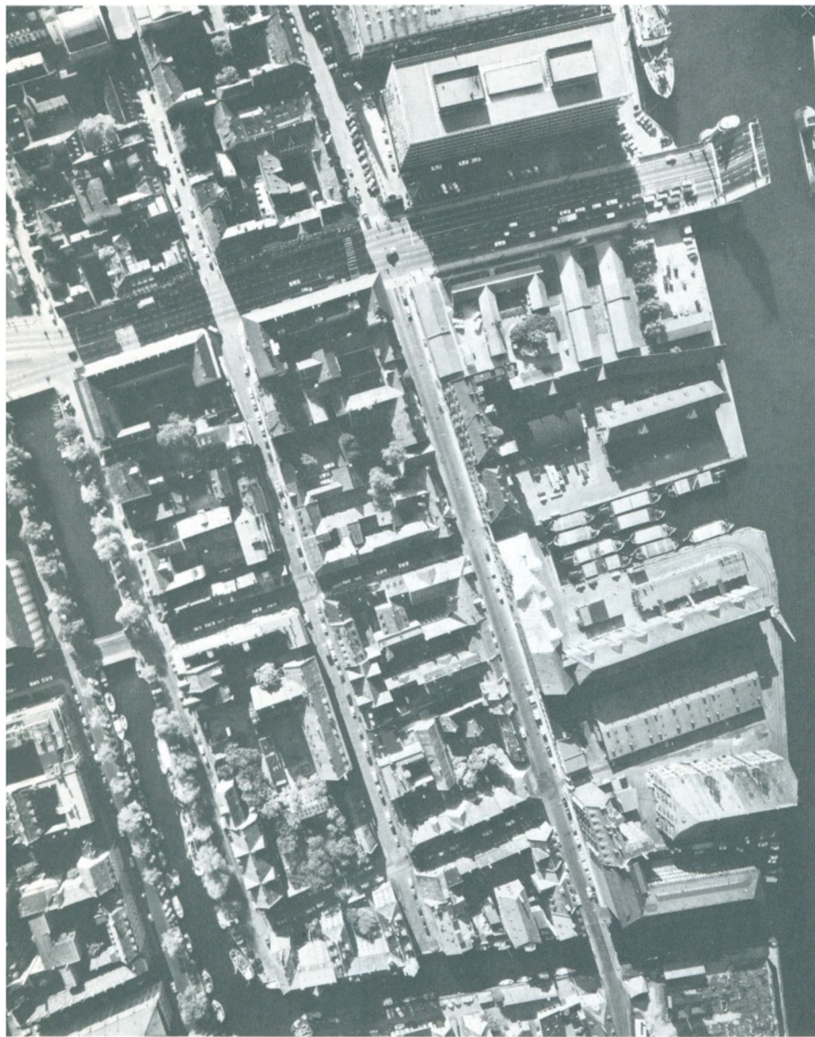
Christianshavn med den regelrette byplanlægning. I øverste højre hjørne ses Knippelsbro. – Landinspektørernes luftfotoopmåling
