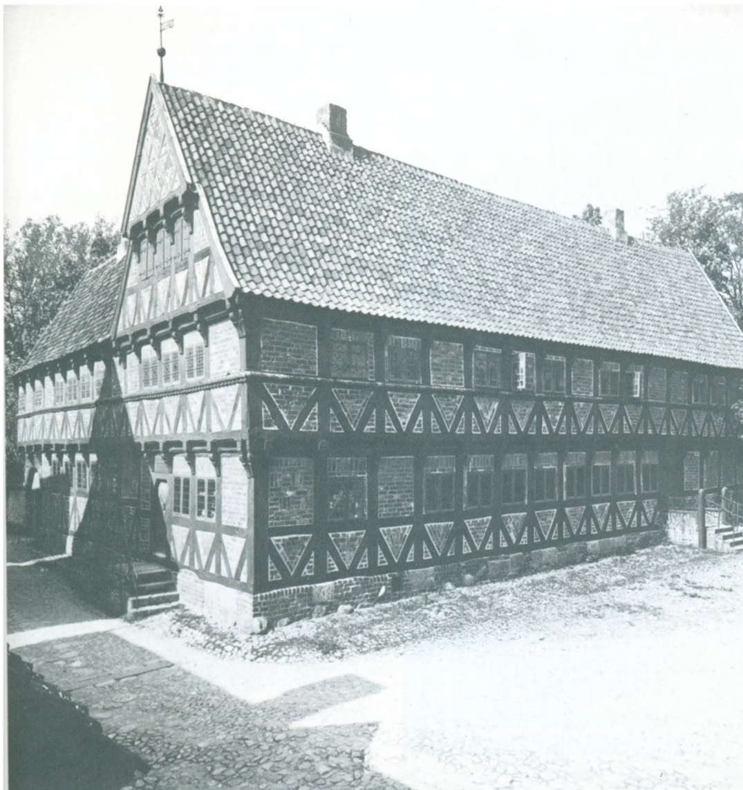
Borgmestergården, opført 1597 i Århus. Bindingsværkshus i 3 stokværk udmuret med tegl til gaden, medens tavlene til gården er lerklinede. Typisk bolig for en velhavende provinsborger. – Den gamle by, Århus
