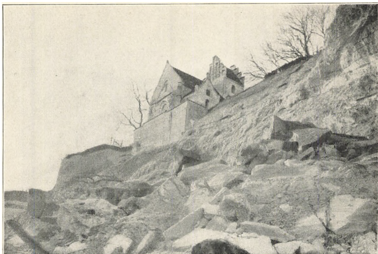
Højerup kirke med støttemuren.
