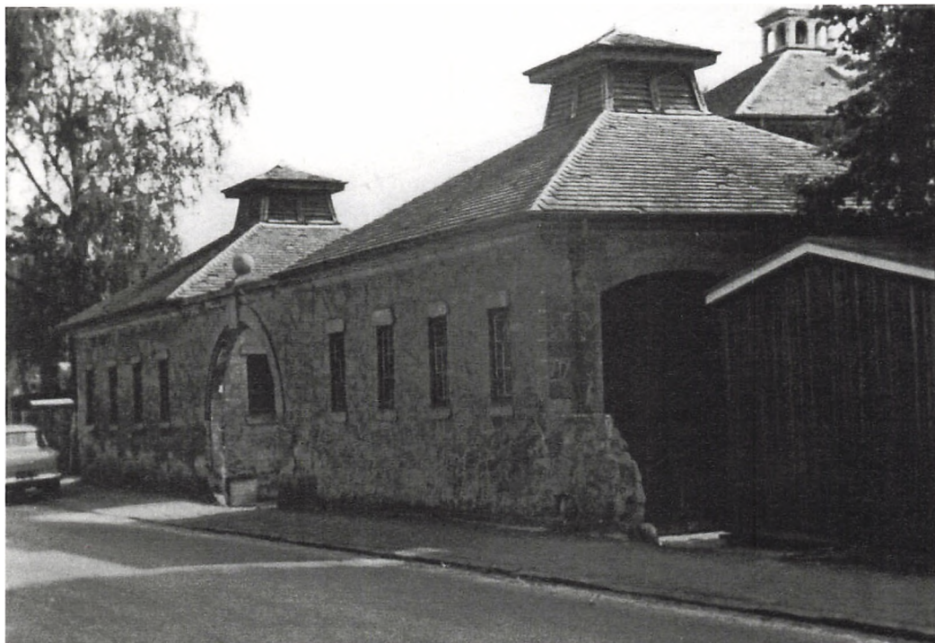
Strandhøjs portbygning - set fra Gylfesvej . Fotograferet af Arne Meyling kort før nedrivningen i starten af 1960'erne.
