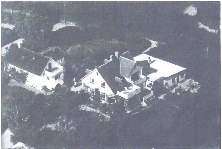
Villa Vraa som det så ud efter opførelsen af det store værksted - fundamentet for fars VVS-firma.
