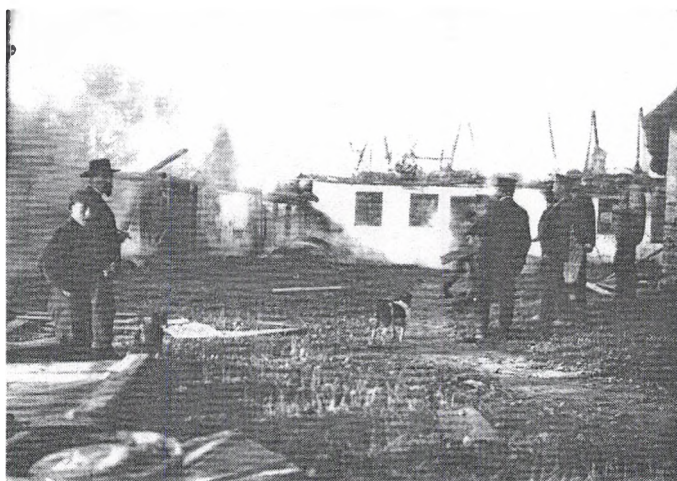
Søbækhuset i flammer i 1907.
