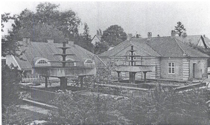
Snekkersten Vandværk i sit endelige udseende med udbygget maskinhus og to paddehatte til iltning af det oppumpede vand. Da det første af disse iltningsanlæg blev opstillet i 1917 klagede naboerne over, at den nye bestyrer sådan kunne få et flot springvand for forbrugernes penge! (Foto: 1969)
