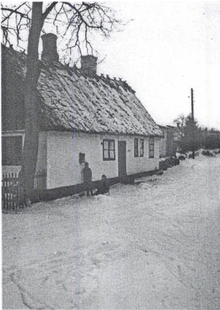
Gl. Tibberupvej nr. 15 (på hjørnet af Sandvejen) som det så ud indtil for et par år siden, hvor huset blev kraftigt moderniseret. Huset er blandt Tibberups ældste husmandshuse. Husets vestende med de højsiddende vinduer er antagelig den ældste del. (Foto ca 1950)
