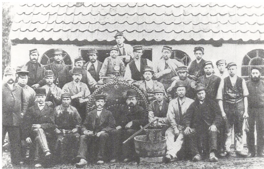
Fig. 5. De ansatte foran snedkerværkstedet (bygning D) ca. 1882. Herren yderst i.v. er fabrikant Carl Petersen. Foran kedlen i.v. konstruktør og værkfører Lars Chr. Nielsen og i.h. fabrikant Sophus Petersen.
