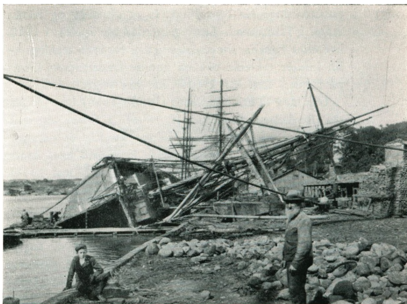
Kjølbaling ved Ringeverven i Fredikstad. Et lignende verft lå i sin tid nedenfor Engebret Nielsens hus på Trosvikstranden.
