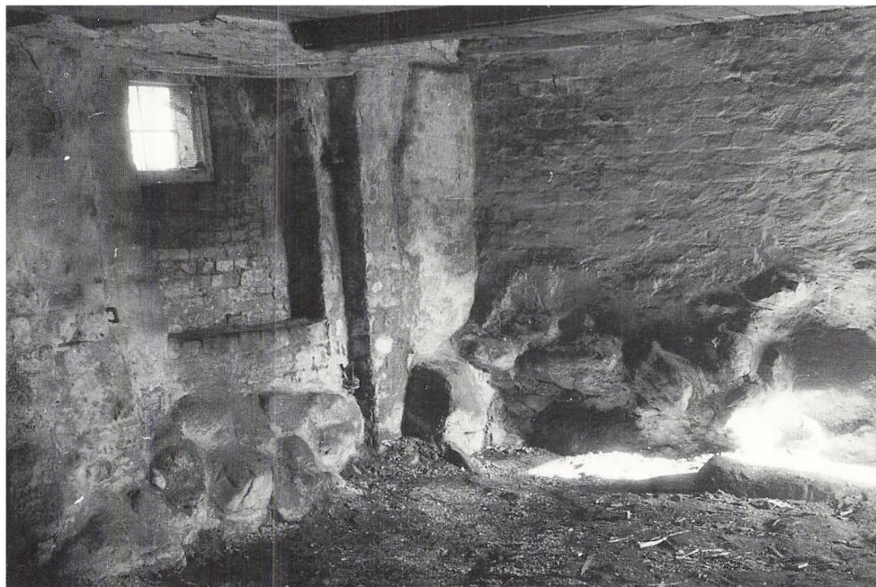
Det nordvestre hjørne af kælderen med rester af en oprindelig kældernedgang. I den rethandede murfals sidder to store nokker. Kældermurene er over kampestenene udført af store mursten, mens tilmuringen af dørhullet er sket med sten i et mindre format. Aage Andersen foto. 1962.
