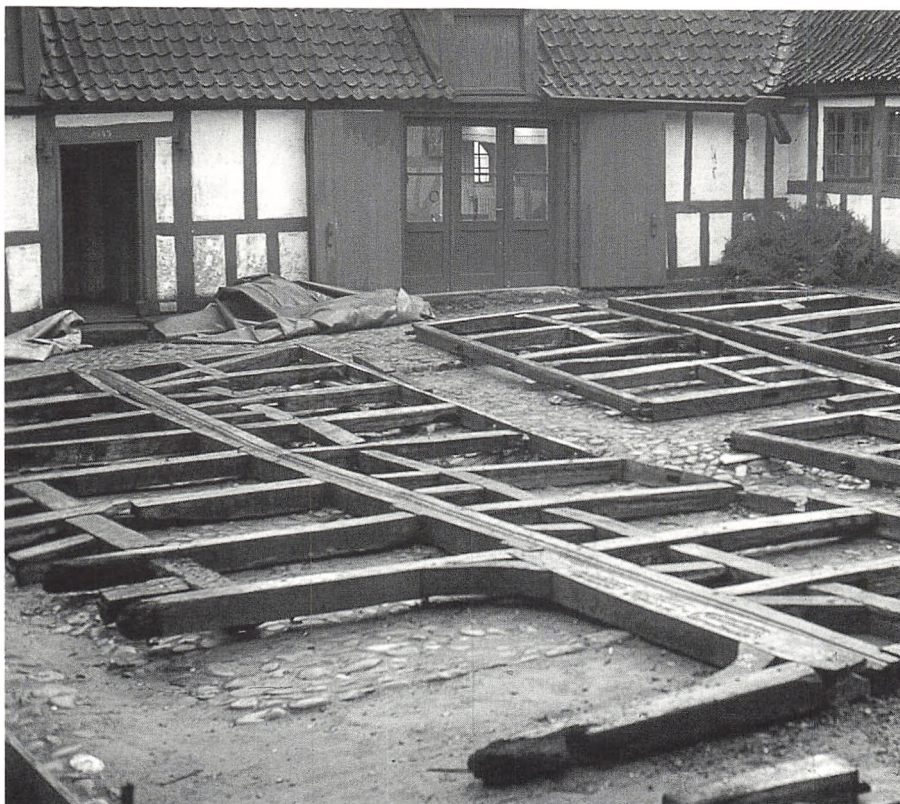
Afbindingen af bindingsværket til Fichs Gaard foregik udendørs i Aarhus Mølles Gaard. Her er gadesidens to stokværk lagt ud sammen med gårdsidens øverste stokværk, således at tømmeret kan vurderes og omfanget af udskiftninger fastlægges. Bue Beck foto 1987.
