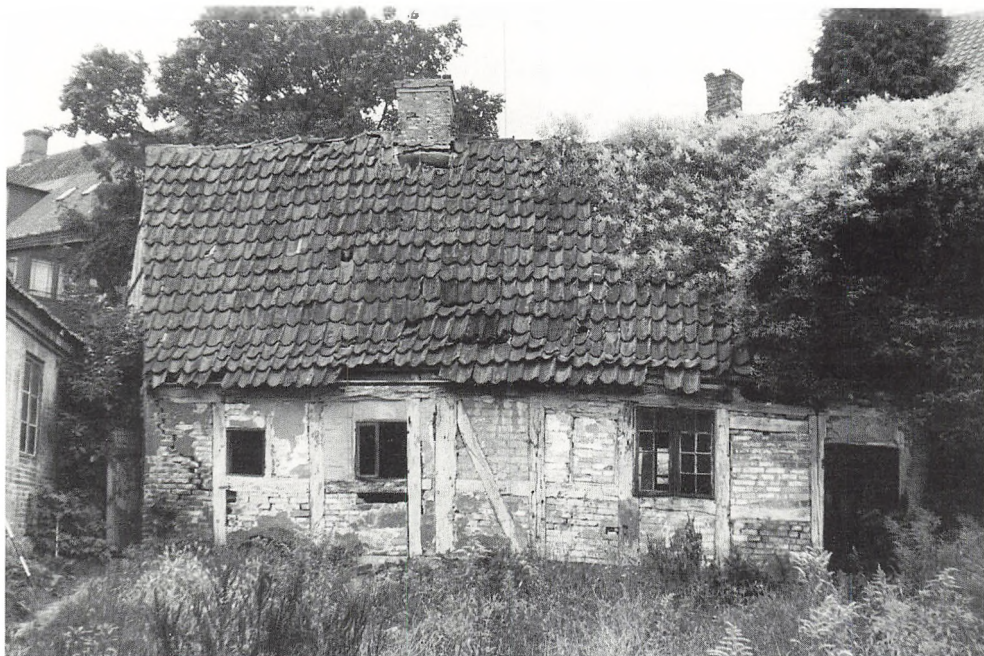
Tværhuset i Fichs Gaard set fra øst i den del af haven, der tidligere udgjorde »Baggaarden«. Husets bindingsværk svarer i konstruktionstype til forhuset, og den skråt afskårne gavl, der følger skellet, har bræddebeklædning på overgavlen. Tværhuset rummede bl.a. »Bagerhuset« og »Bryggerhuset« samt en gennemgang mellem »Gaarden« og »Baggaarden«. Aage Andersen foto. 1961.
