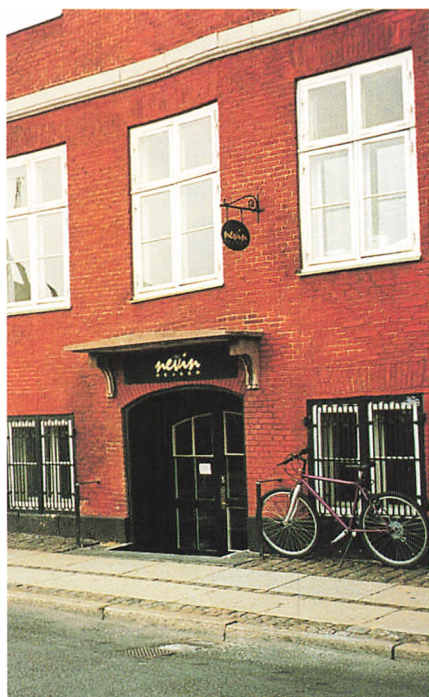
Skur over kældernedgang i Nybrogade 24 i København.
