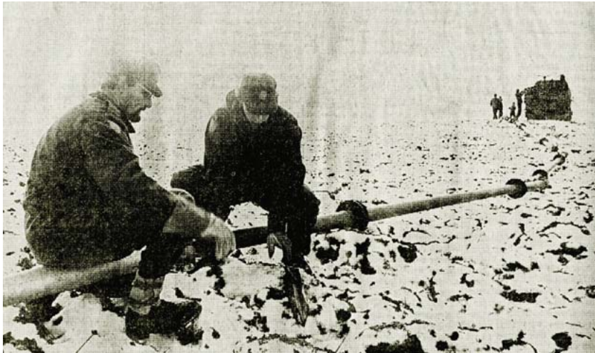
I løbet af weekenden og mandagen udlagde civilforsvaret en 2,5 km lang rørledning fra vandværket i Maugstrup til Simmersted. Foto: Lokalhistorisk arkiv for Vojens-området.
