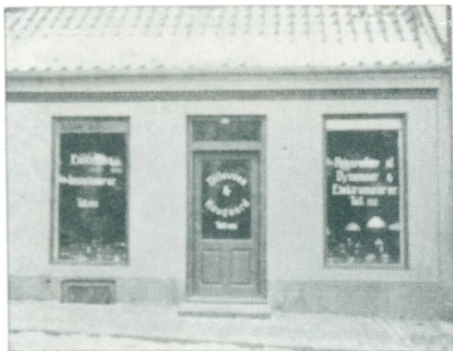
Ditlevsen og Haugaards Installationsforretning.
