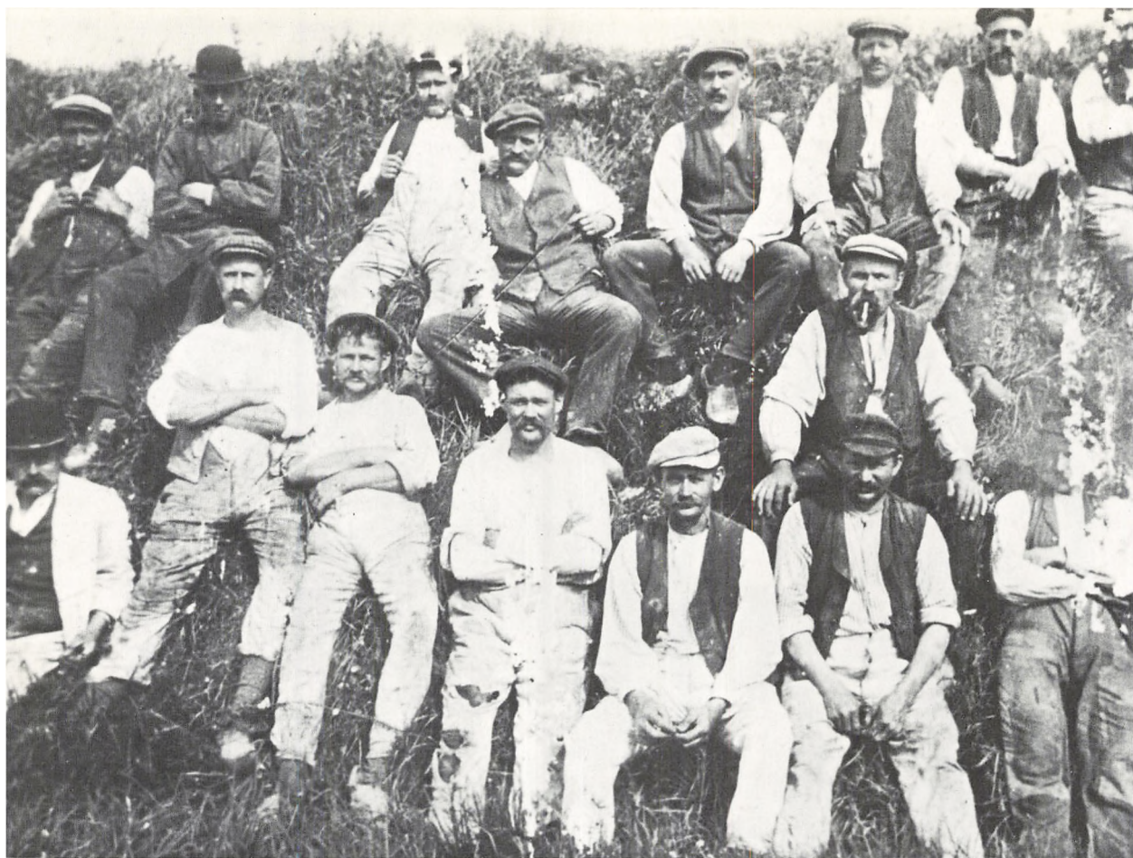
72 Kommunale arbejdere ved gas- og vandrørsnedlæggelserne i 1906
