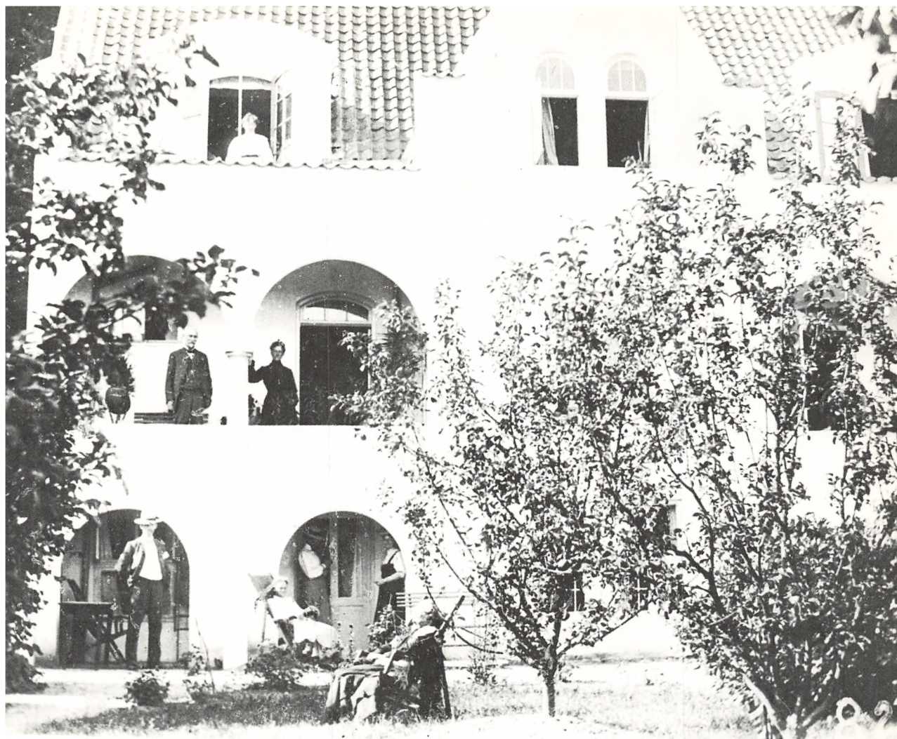
41 Pensionat »Solhjem« på Sofievej
