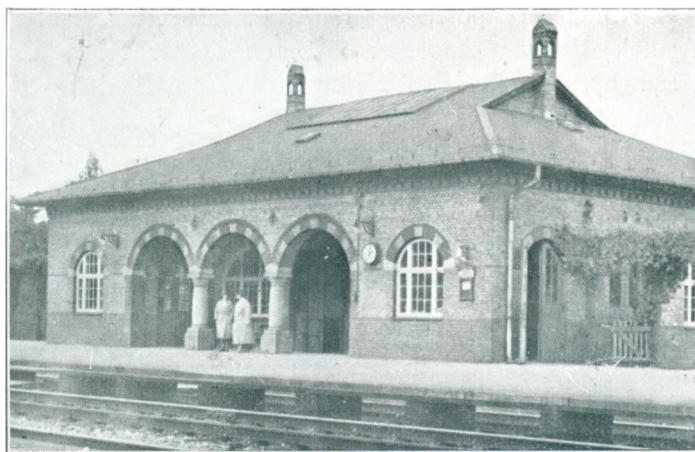
Rungsted „Østre Station“.
