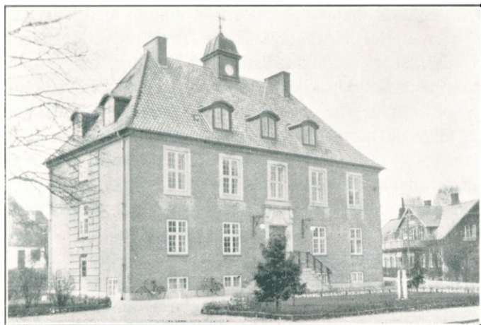
Birkerød Raadhus, bygget 1925.
