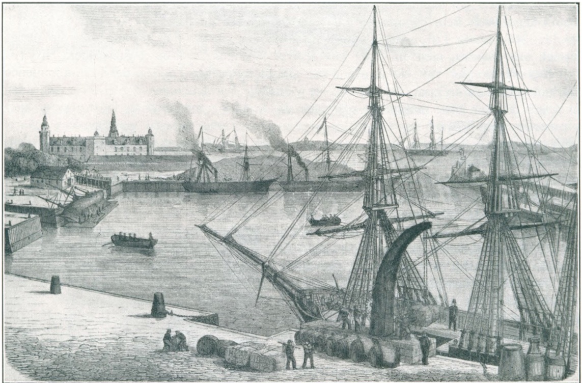
Det nye Havneanlæg fra 1860.
