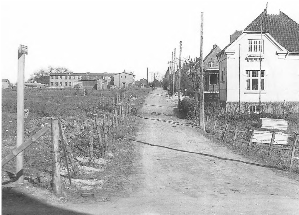
Energivej set fra Gl. Hobrovej. Villaen i forgrunden er nr. 73, der er bygget i 1908. Til venstre for vejen, bag vejskiltet, anes et stykke af det gamle dige omkring Næst Nyvang. Et par gadelamper fortæller, at urbaniseringen er begyndt. Fotografi fra o. 1935.
