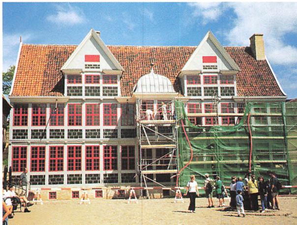
Montmestergården 15. juli 2000. Den karakteristiske kvaderbemaling er nu synlig, og tagrendernes vandspy er monteret.
