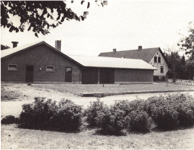
Matr. nr. 20 a, Lundsgård, Korsgade 4, genopført efter brand 1973. (Fot. Jørn Andersen).
