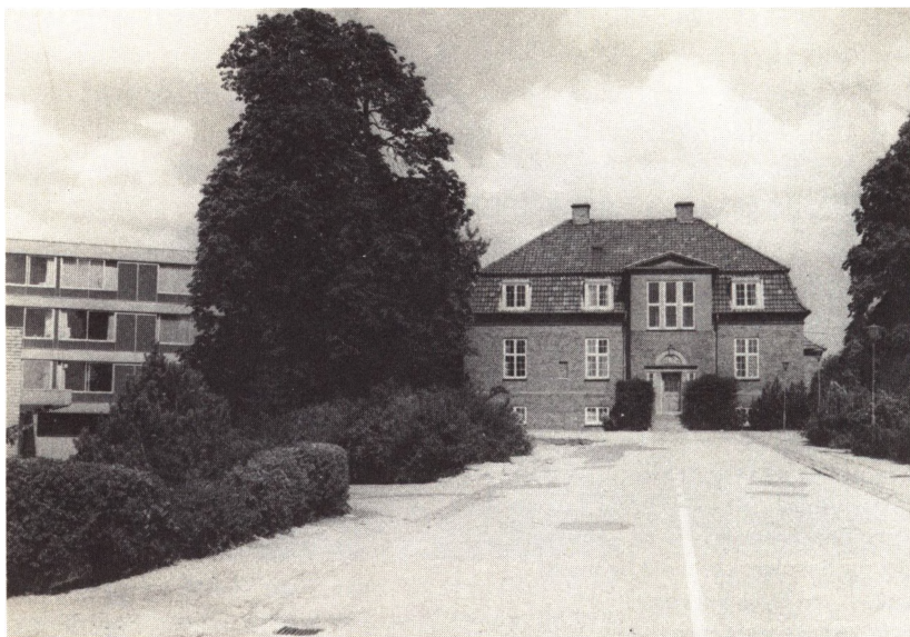
Næsbyhovedgård, der med tilhørende jord har udgjort ét ejerlav. I årene 1894–1960 er frasolgt nær 200 grunde til parcelhuse. Den resterende jord overtoges 1960 af Næsby Boligselskab, der har opført flere boligkomplekser, navngivet efter markskiftet Fuglsang-løkken, der findes anført i markbogen fra 1682. (Fot. Jørn Andersen).
