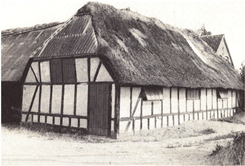
Matr. nr. 10 b, Søhusvej 188 opført omkr. 1854. Oprindeligt var alle længer i bindingsværk og med strå, men hen ad vejen er der sket fornyelser, hvilket tydeligt fremgår af ovenstående billede! (Fot. Jørn Andersen).
