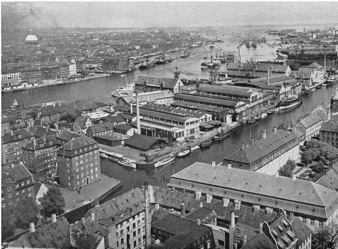
Burmeister & Wains Maskinfabrik paa Christianshavn.
