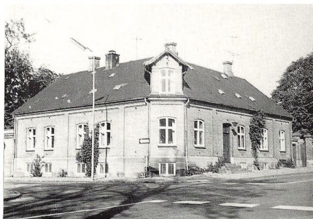
Fabrikant P. H. L. Blochs ejendom hjørnet af Danmarksgade og Kongensgade.
