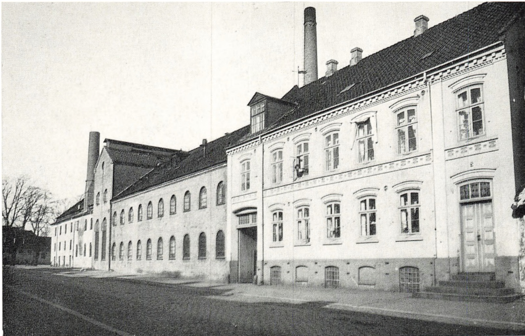
Spritfabrikken i Norgsgade ca. 1920.
